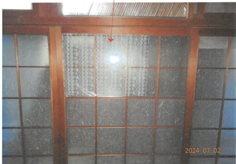
⑥ (1階中央和室 プラスチック障子紙補修箇所)
