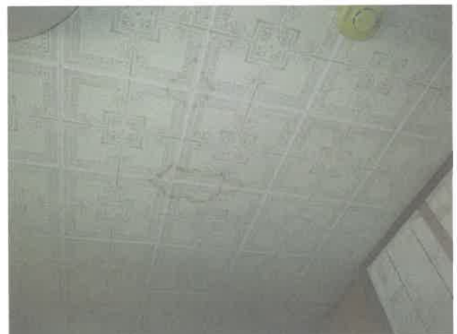
2階 洋室天井付近
