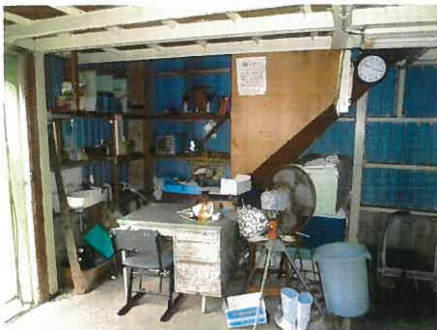
7 1F階段 付近の 状況
