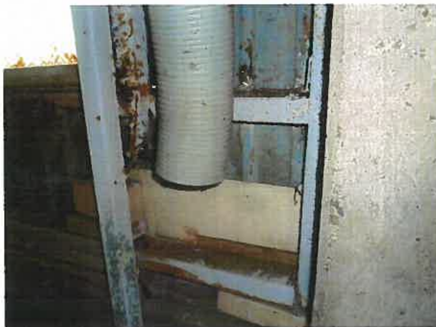
14 同上 壁の穴を 塞いでいる 状況
