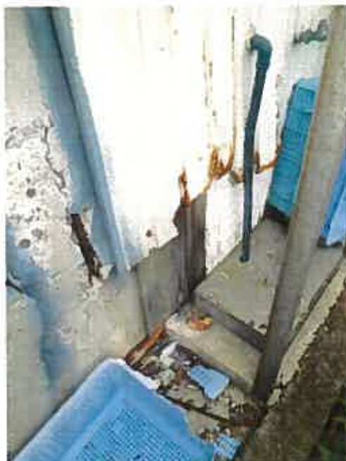
6 トタンの穴を 塞いでいる 状況
