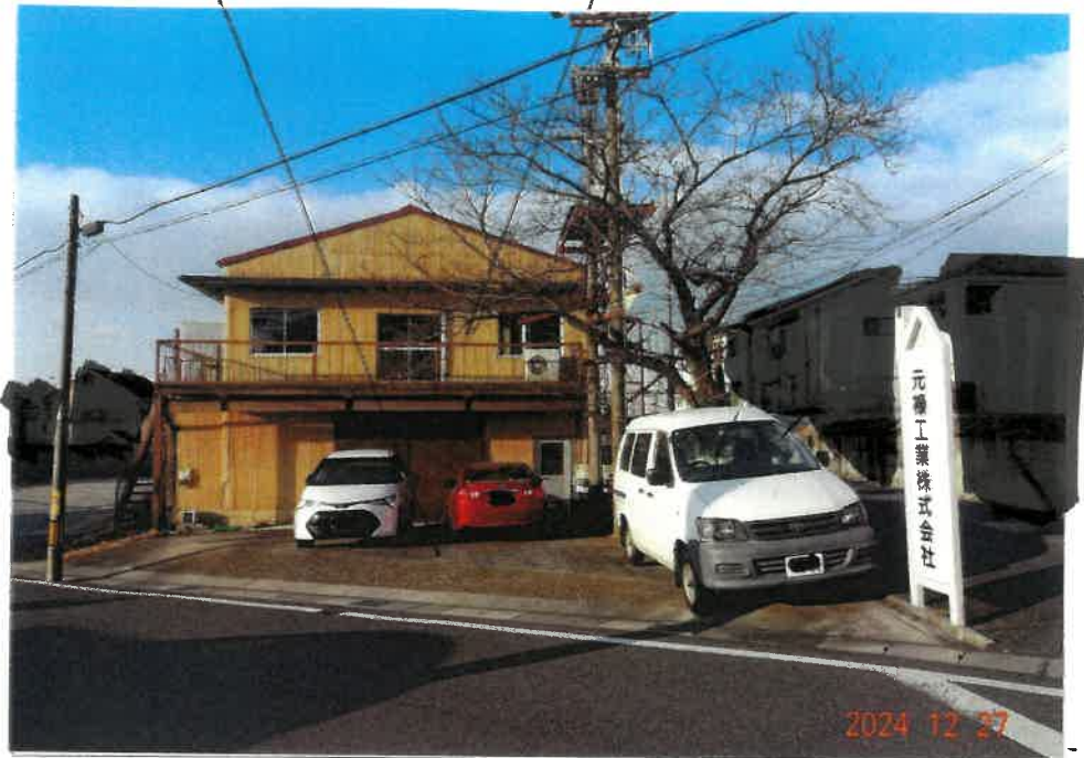
① 東側から見た物件 1 土地及び物件 2 建物の状況
