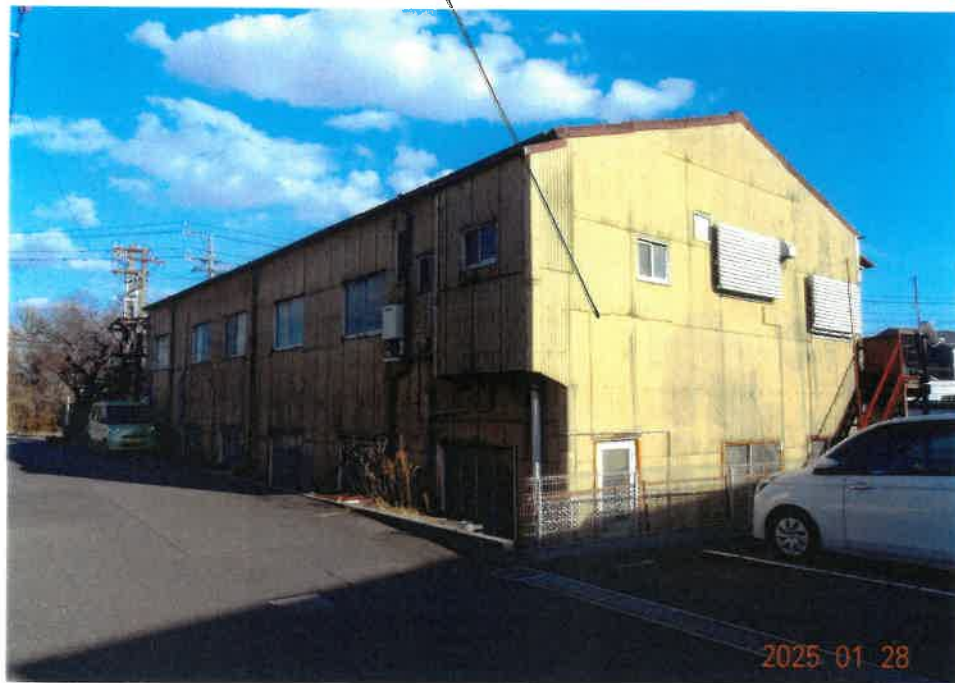
② 西側から見た物件 2 建物の状況
