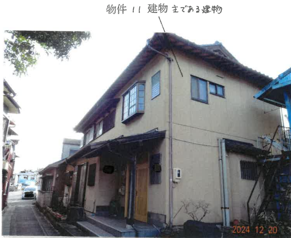
② 物件 11 建物主である建物の状況
