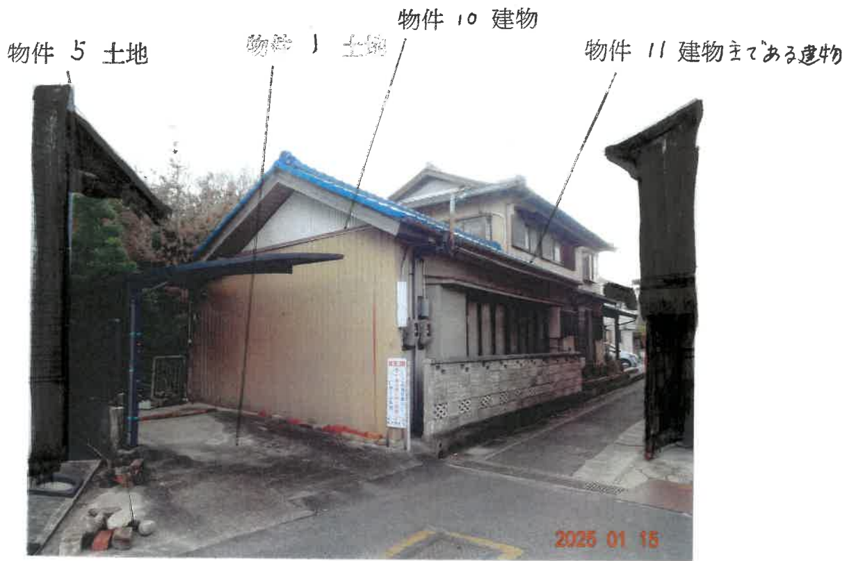
① 東側から見た物件 1 土地、物件 10 建物及び物件 11 建物主である建物の状況
