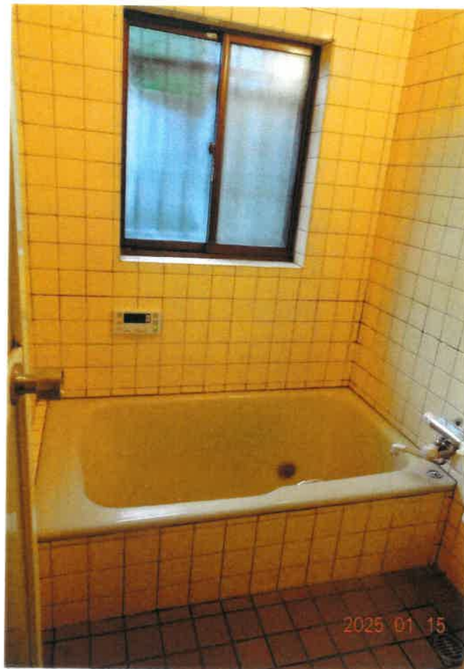
⑧ 物件11建物主である建物屋内の状況（1階 浴室）
