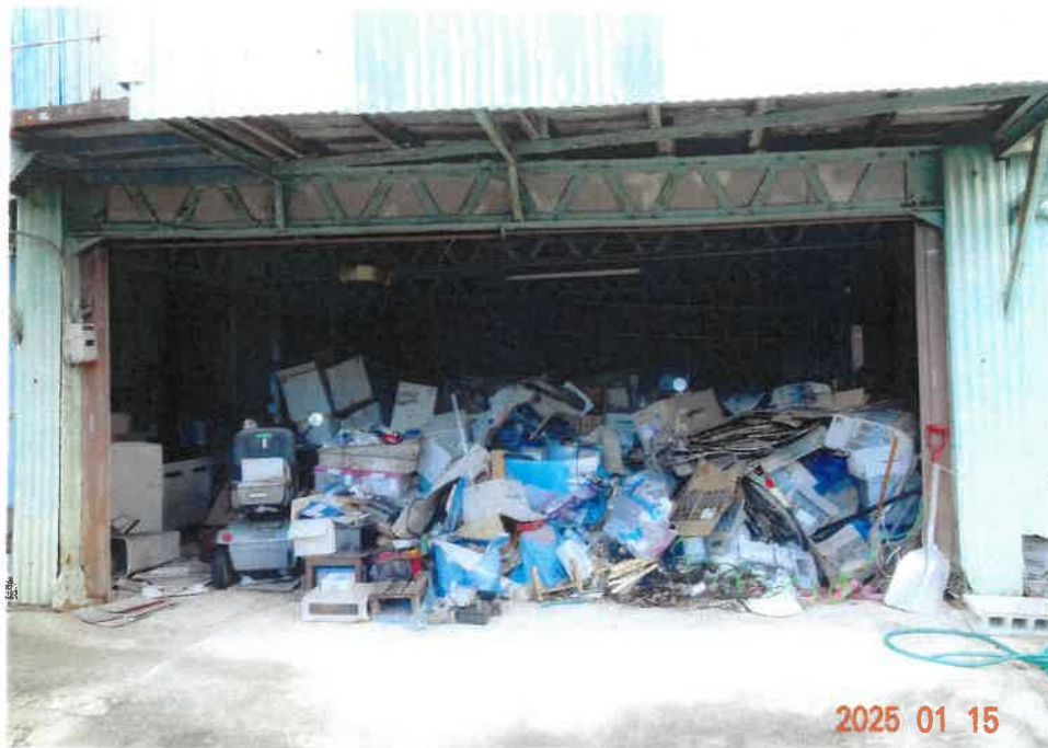
⑪ 物件11建物未登記附属建物屋内の状況（1階 車庫）
