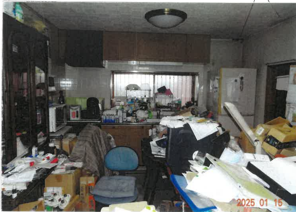
⑦ 物件11建物主である建物屋内の状況（1階 ダイニングキッチン）
