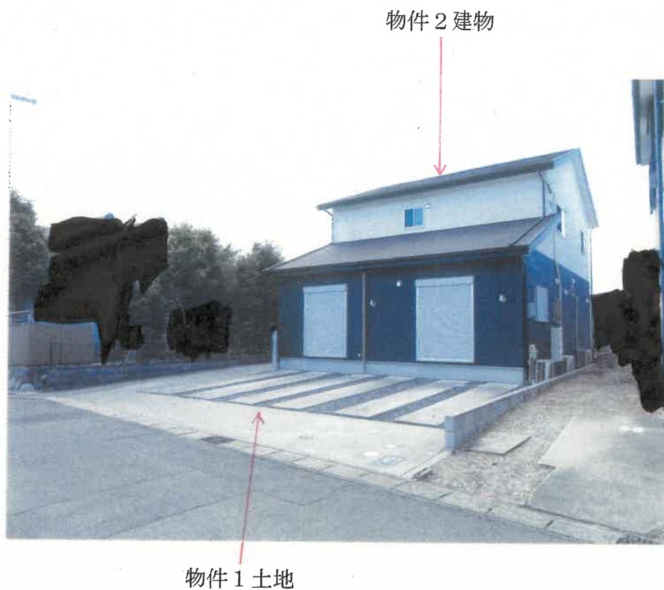
① 物件1 土地、物件2 建物の外観（北方向から撮影）
