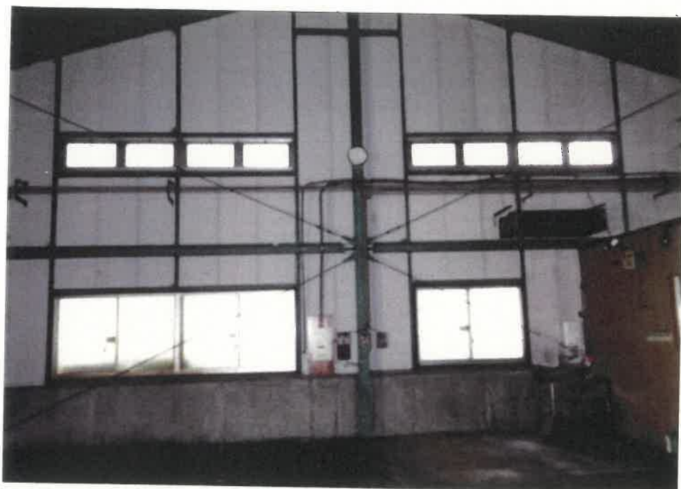
③ 屋内の状況（物件2建物主である建物（工場））
