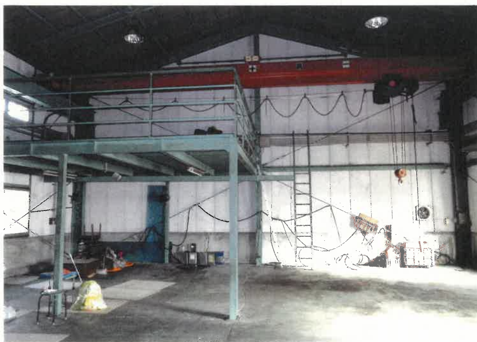
② 屋内の状況（物件2建物主である建物（中二階及び工場））
