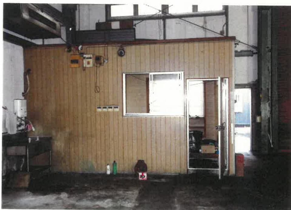
④ 屋内の状況（物件2建物主である建物（事務所））
