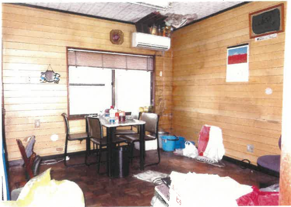
⑤ 屋内の状況（物件2建物附属建物（1階事務所））
