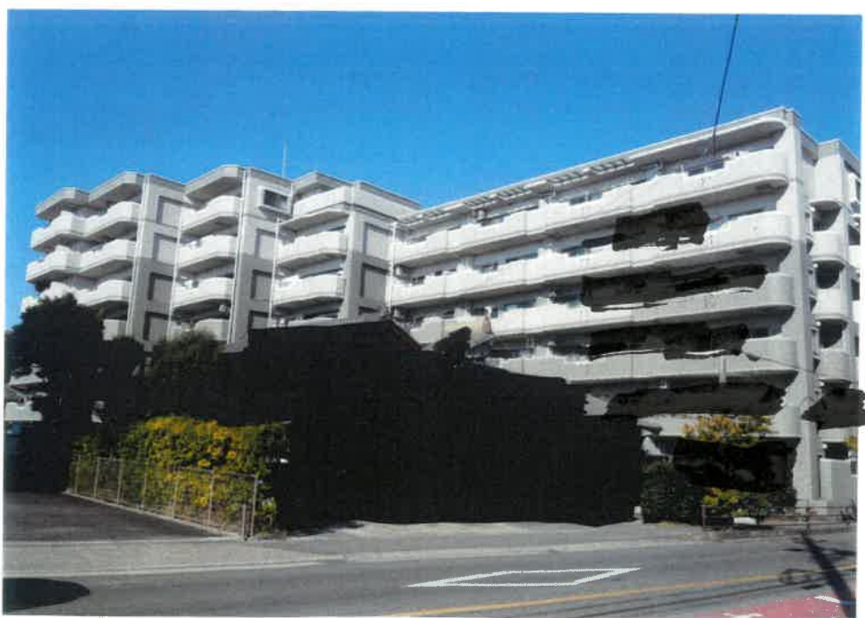
② 物件 1 建物を含む一棟の建物の外観（東方向から撮影）
