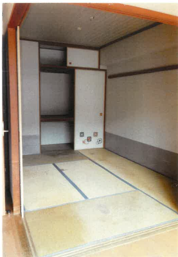
④ 屋内の状況（和室）
