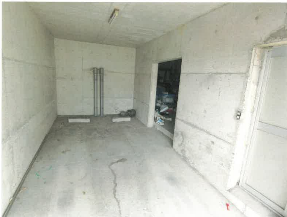
10 物件2建物内部の状況（車庫1）
