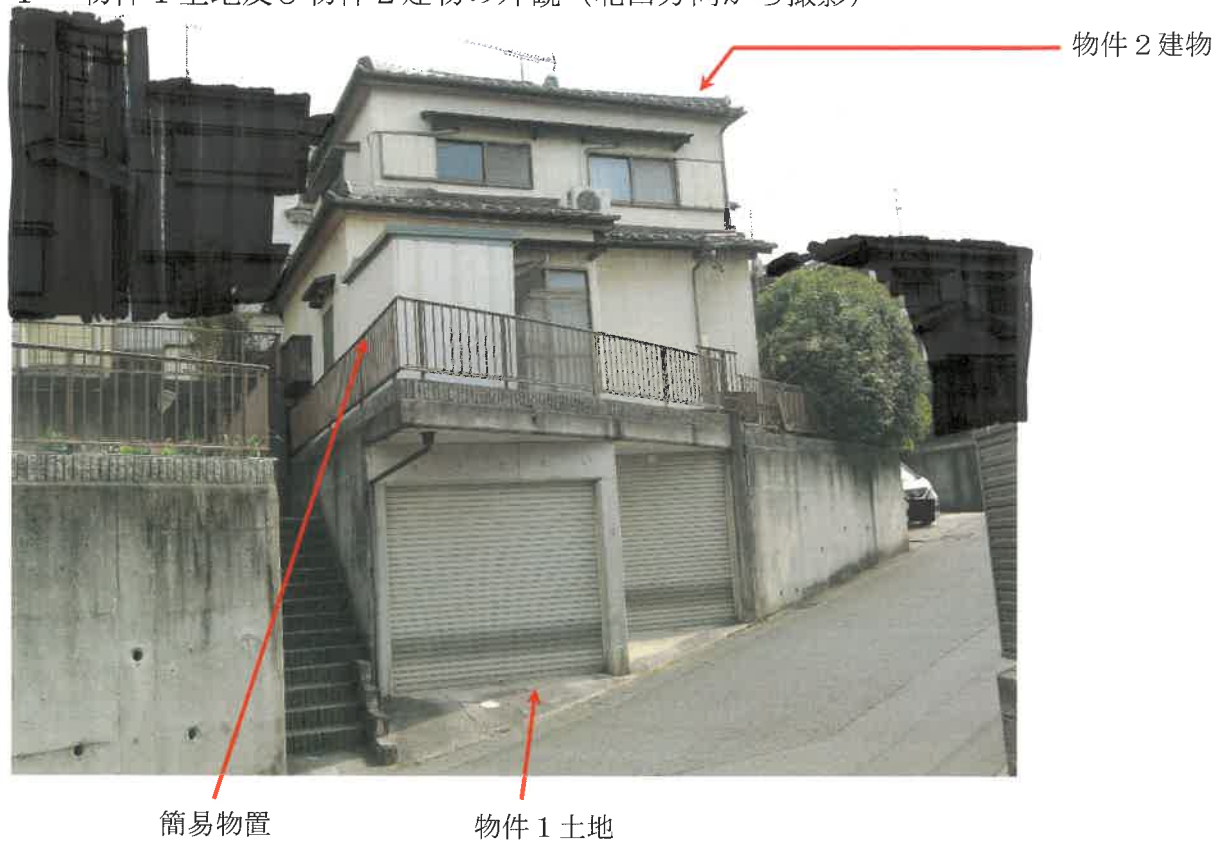
1 物件1 土地及び物件2 建物の外観（北西方向から撮影）
