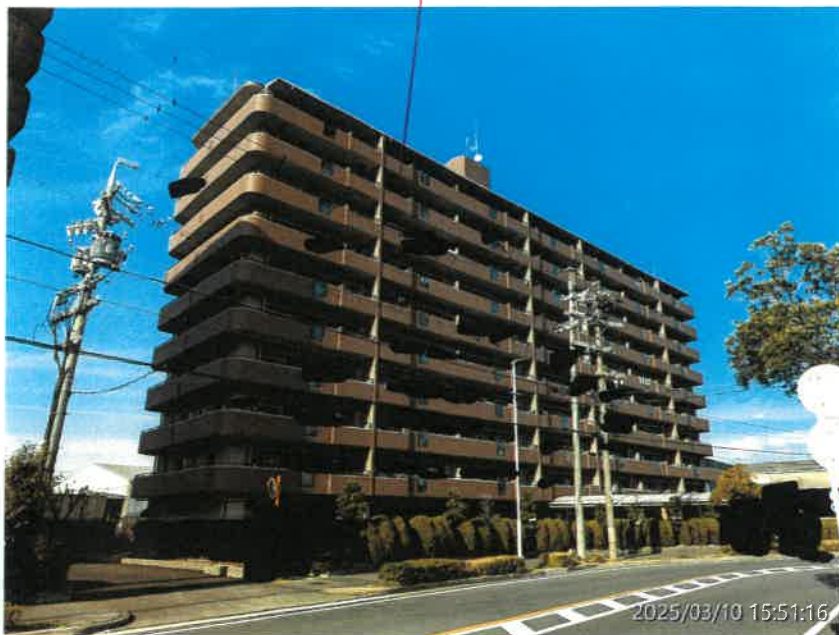
物件1 建物を含む一棟の建物 (ラビデンス荒子川公園Ⅲ番館)
