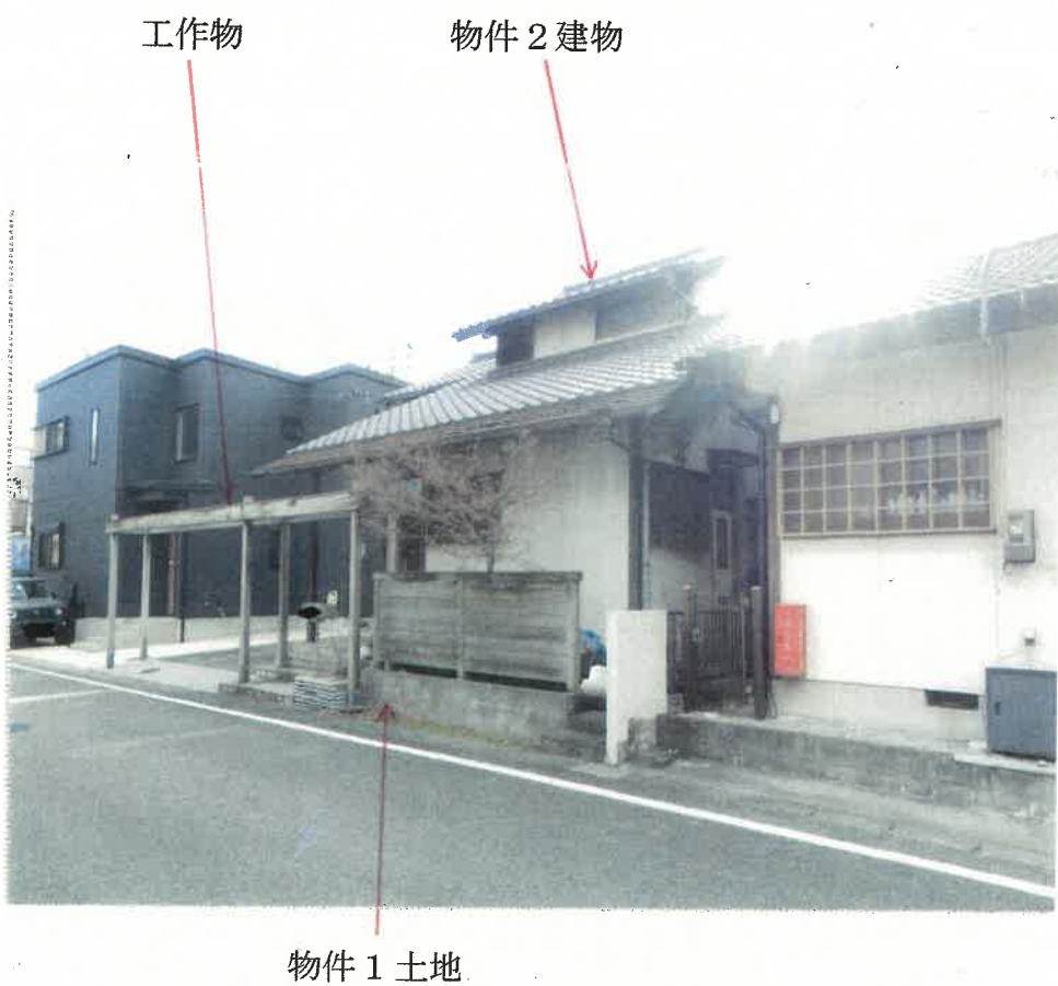
② 物件1土地、物件2建物の外観（北西方向から撮影）
