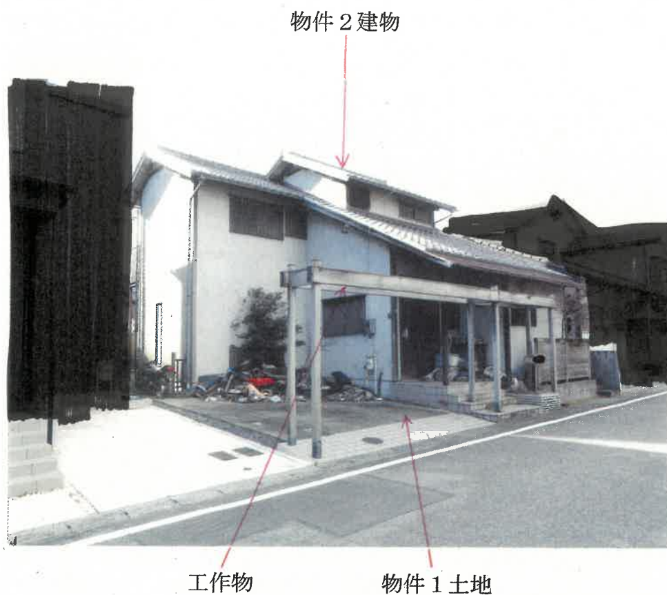
① 物件1土地、物件2建物の外観（北東方向から撮影）
