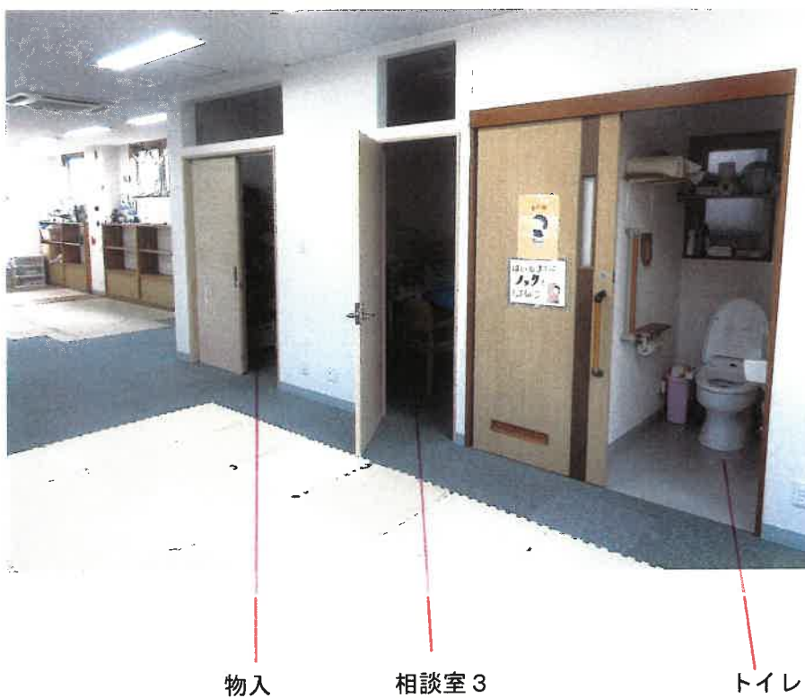
屋内の状況（1階 物入・相談室 3・トイレ）
