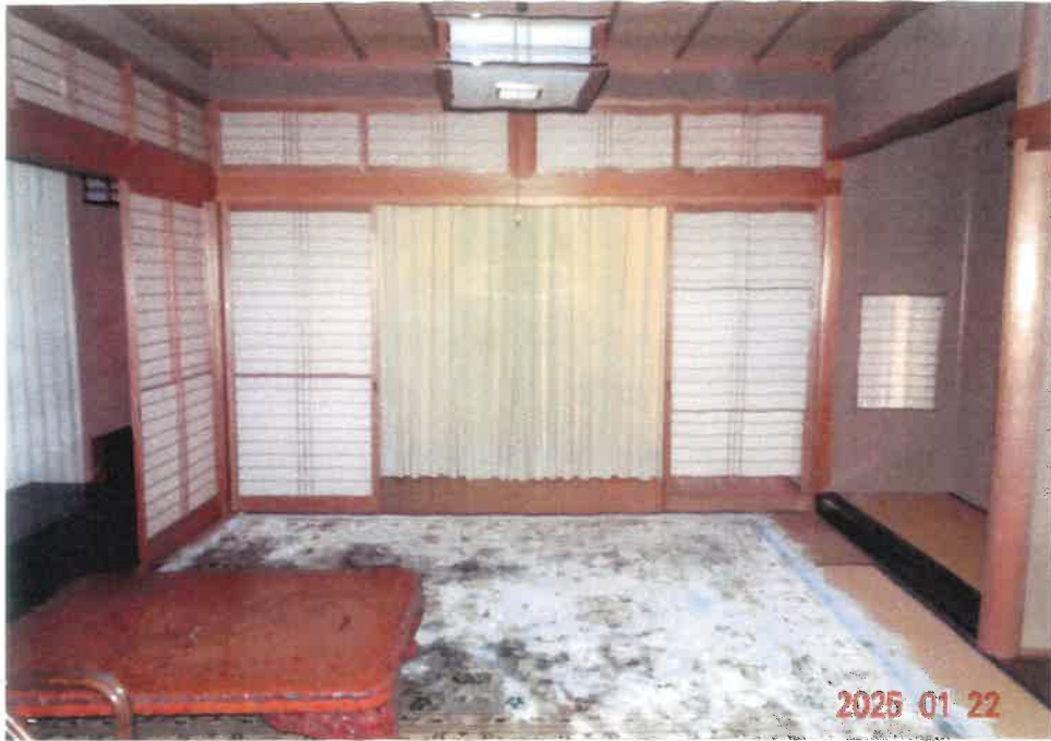
⑦ 物件3建物主である建物屋内の状況（1階 和室 3）
