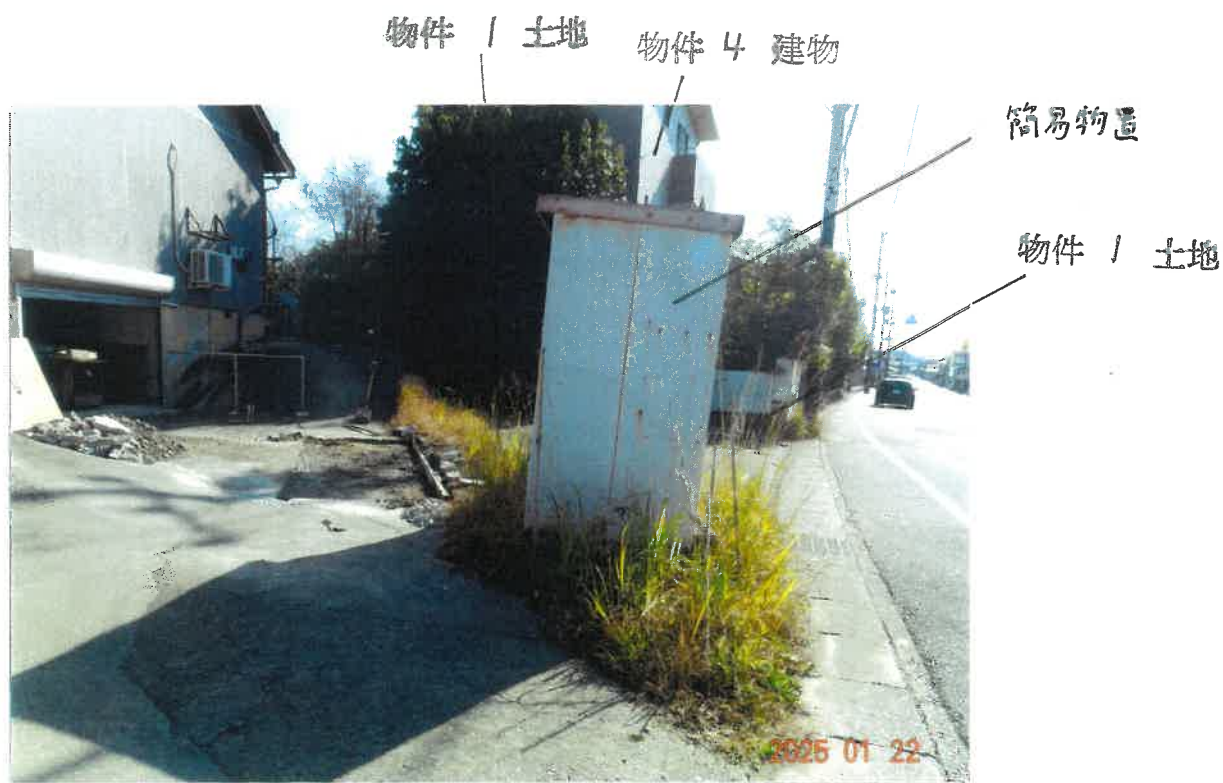
② 北側から見た物件 1 土地の状況
