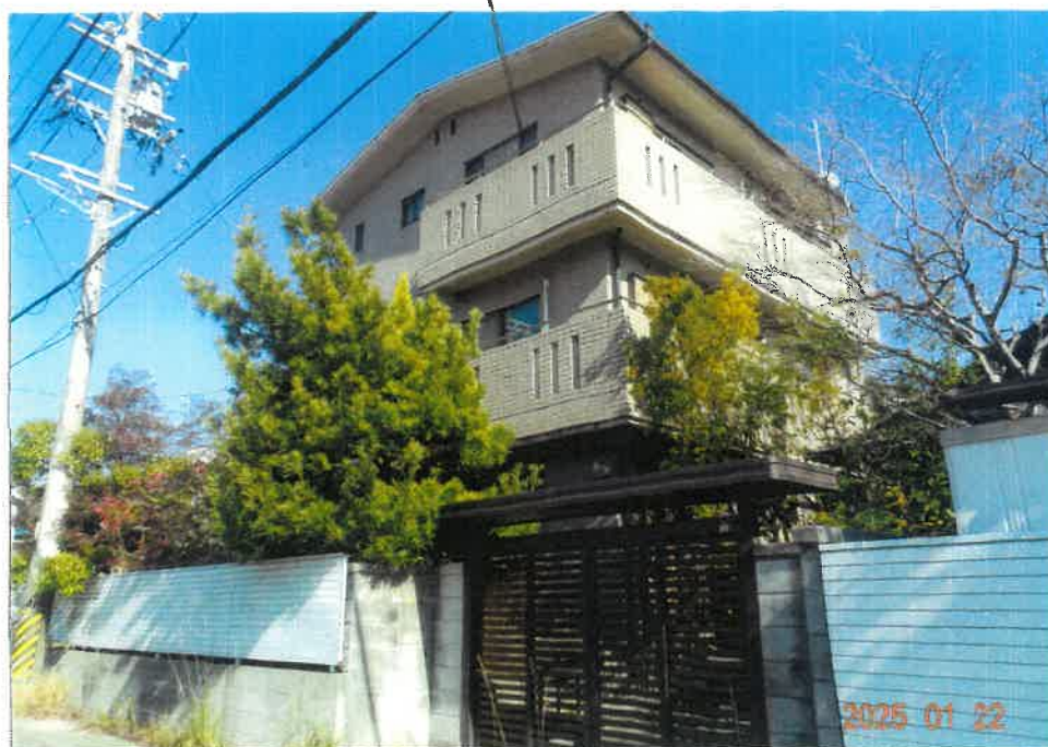
⑥ 物件 4 建物の状況
