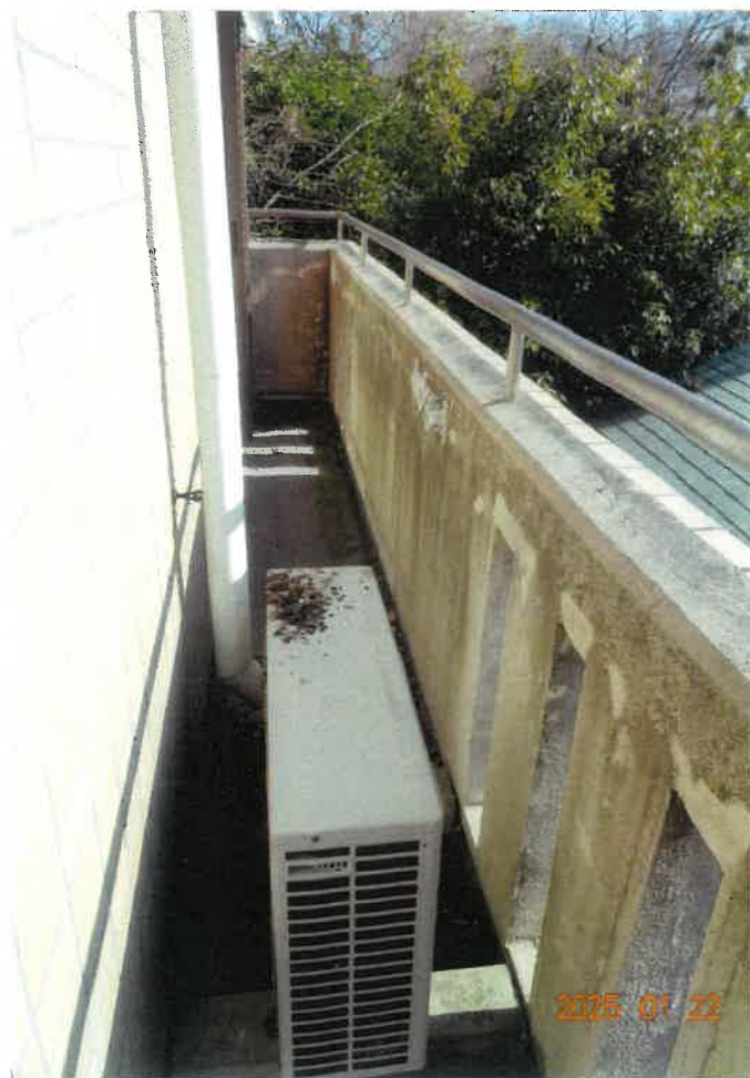
⑯ 物件4建物2階ベランダの状況
