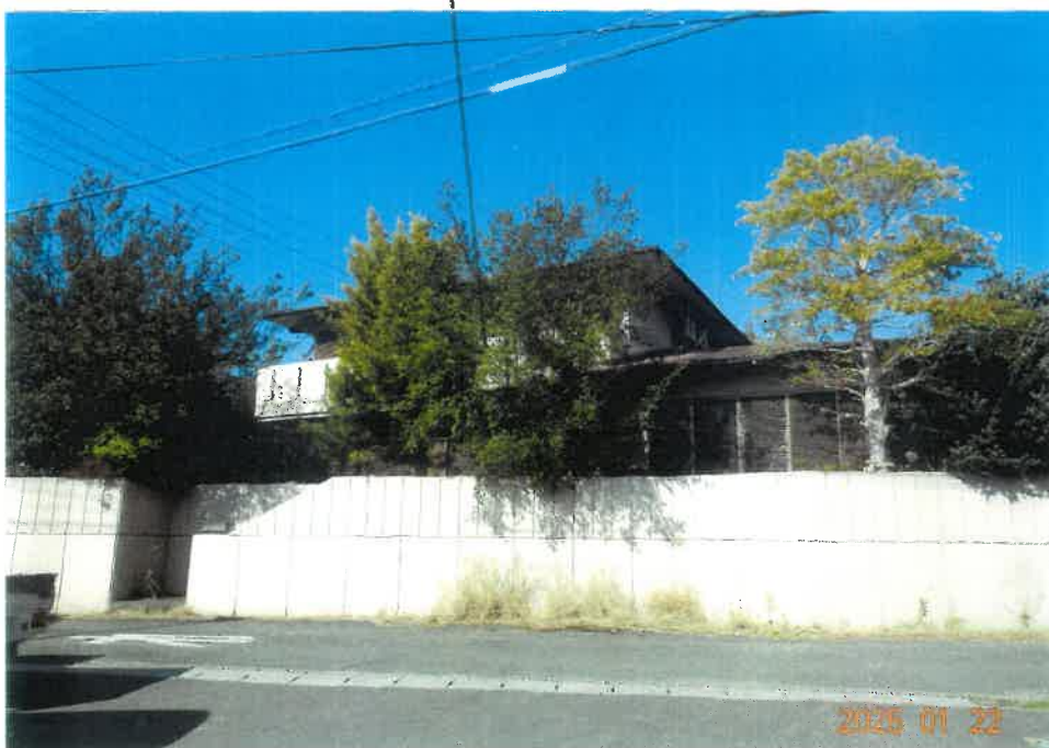
④ 物件3建物主である建物の状況
