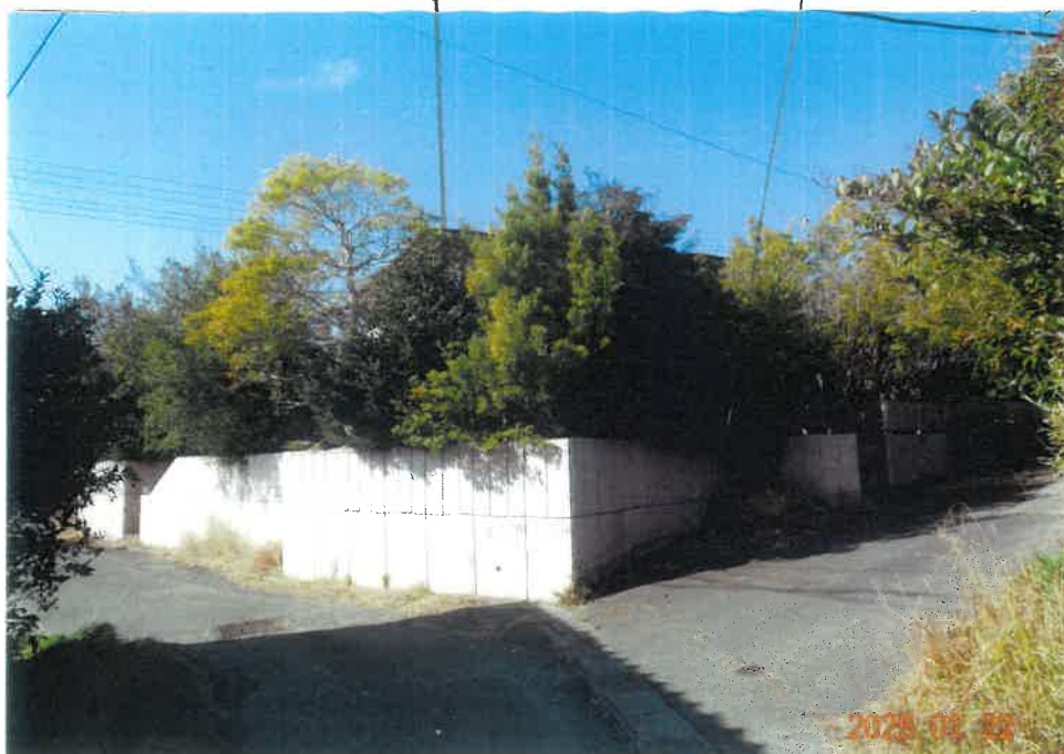
③ 南東側から見た物件2土地、物件3建物主である建物の状況
