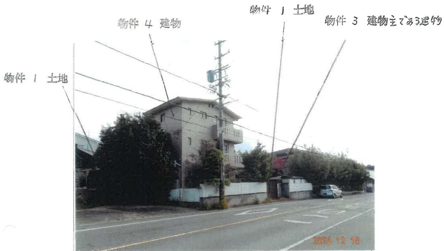
① 北西側から見た物件 1 土地、物件 3 建物主である建物及び物件 4 建物の状況
