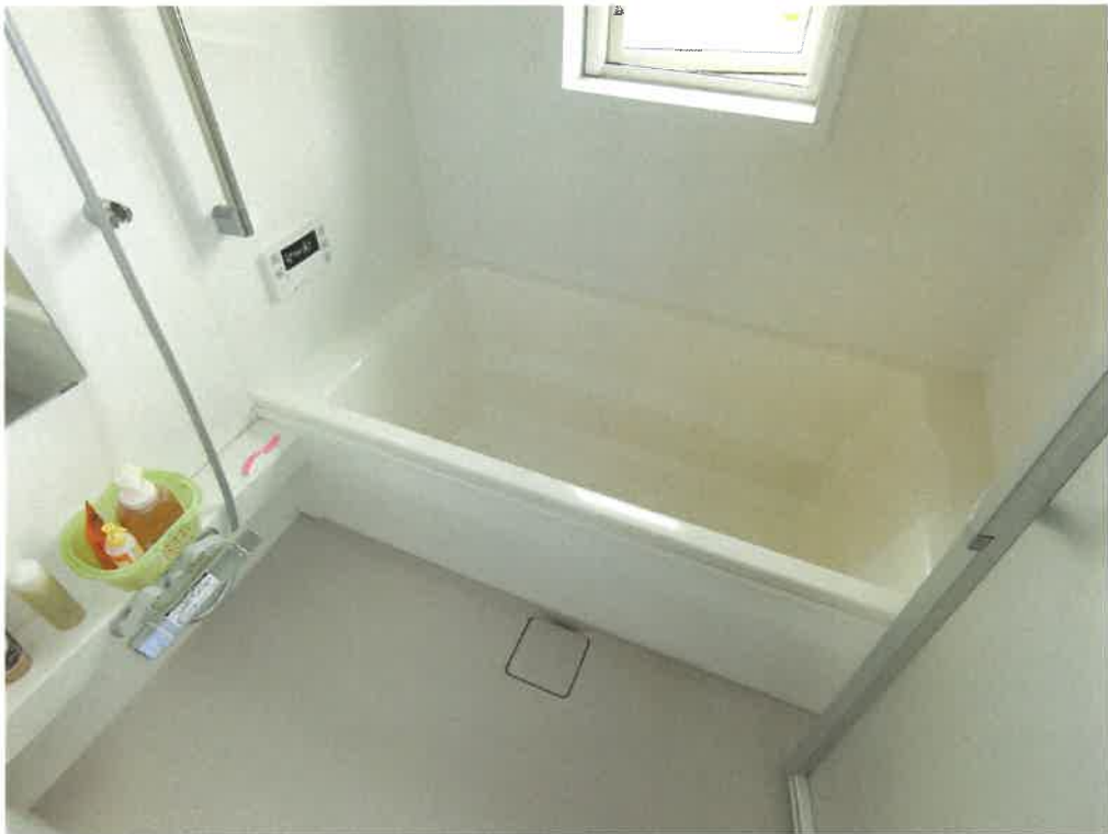
8 物件4建物内部の状況（浴室）
