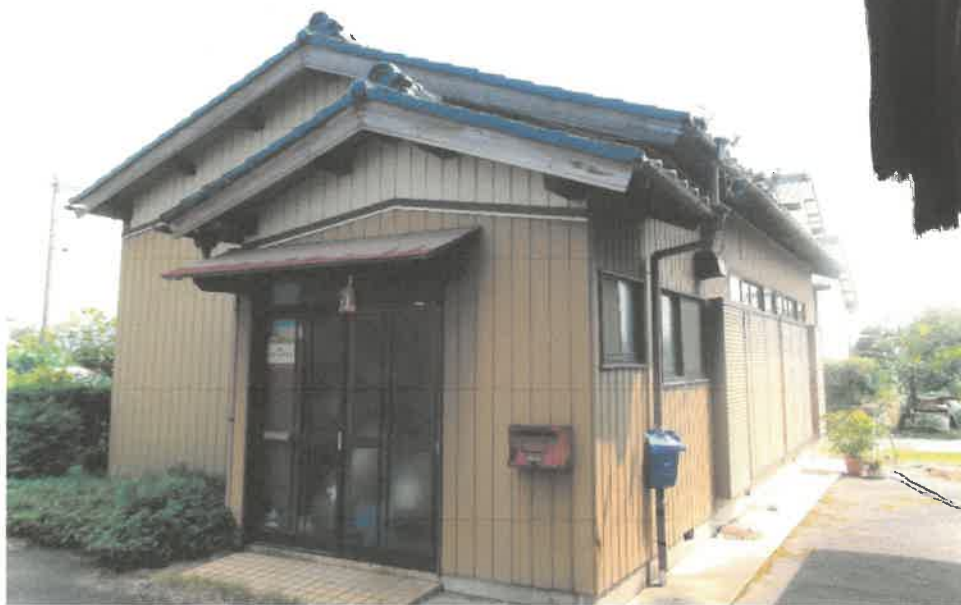
① 物件5土地を含む物件4建物の外観
