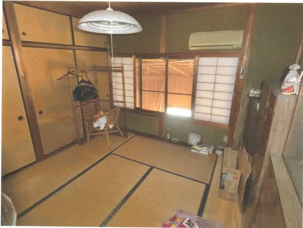
8 物件1主である建物内部の状況（和室1）
