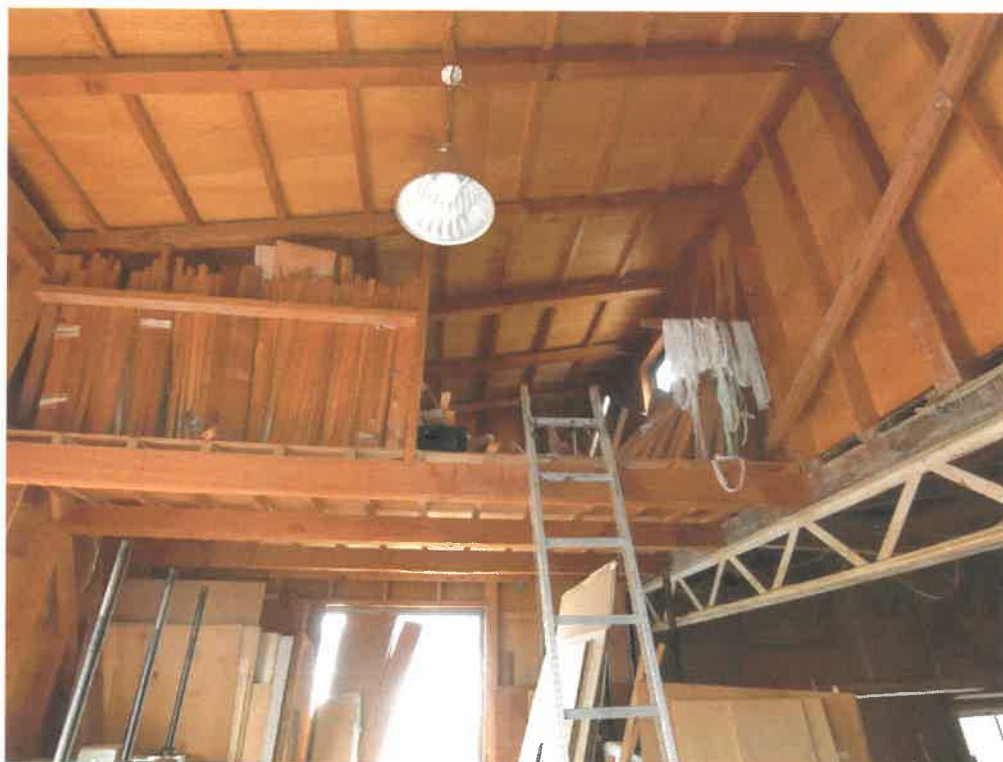
6 物件1主である建物内部の状況（物置2）
