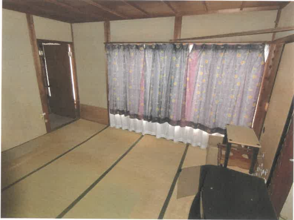
1 1 物件 2 主である建物内部の状況（和室 5）
