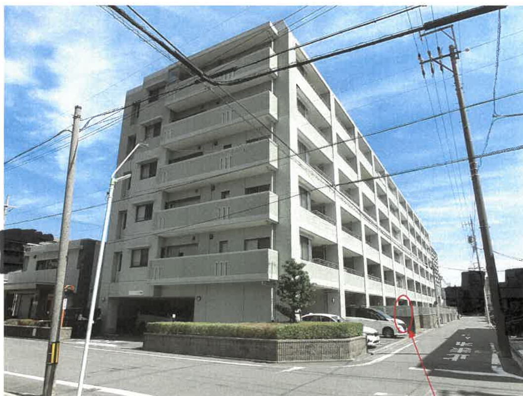
専有部分の建物
