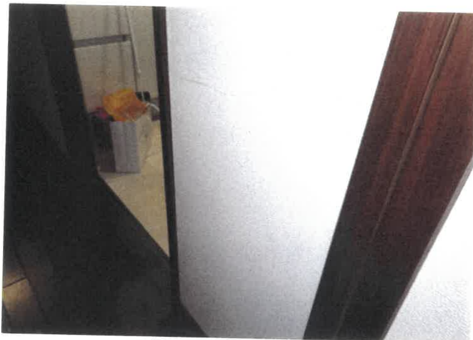
⑤ 屋内の状況（リネン庫の廊下側の壁の様子）
