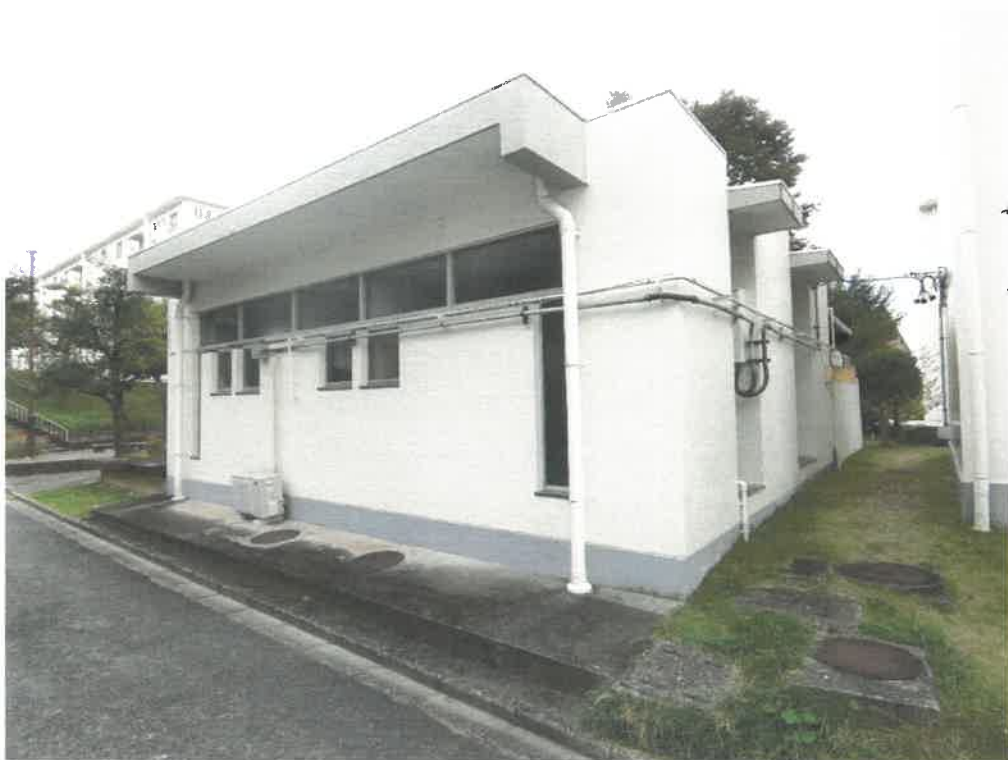
4 物件2建物の外観（北西方向から撮影）
