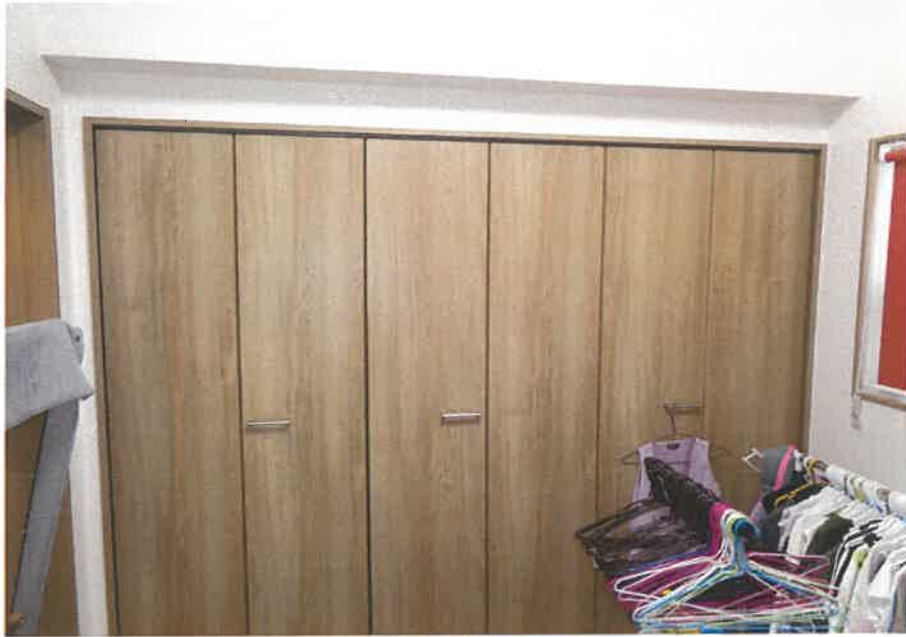
屋内の状況 洋室3
