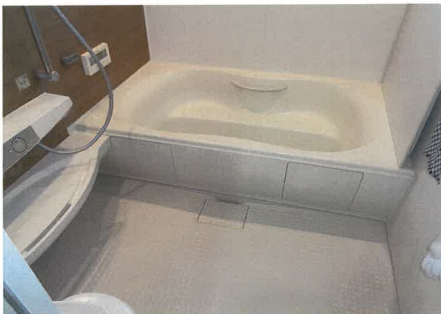
屋内の状況 浴室
