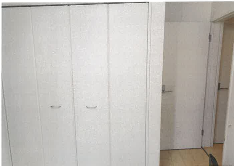
屋内の状況 洋室2
