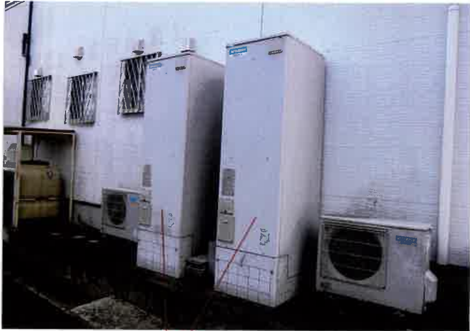
⑦屋外の状況
