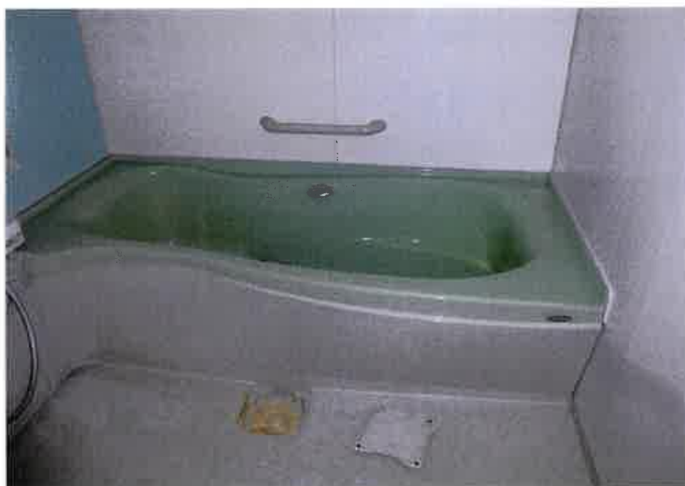
⑥屋内の状況 浴室
