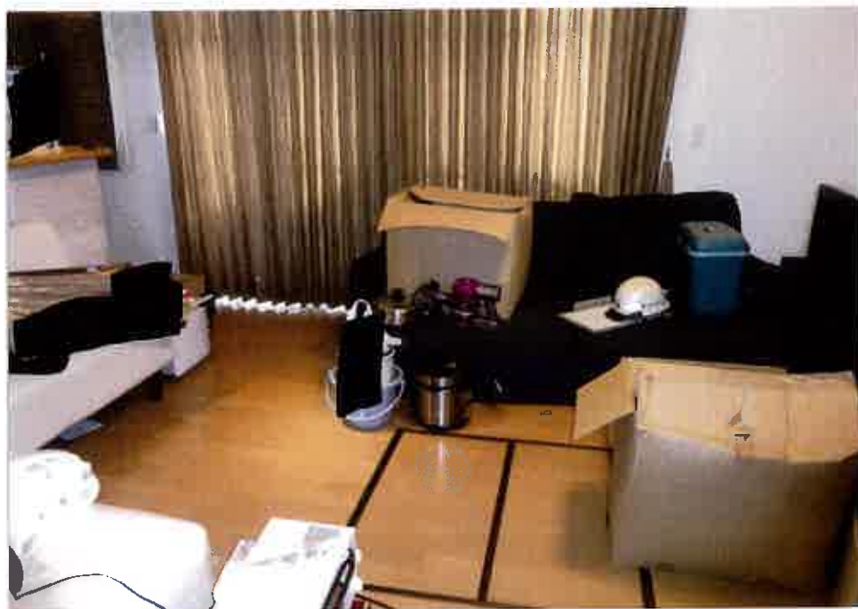
④屋内の状況 1階LD(壁)
