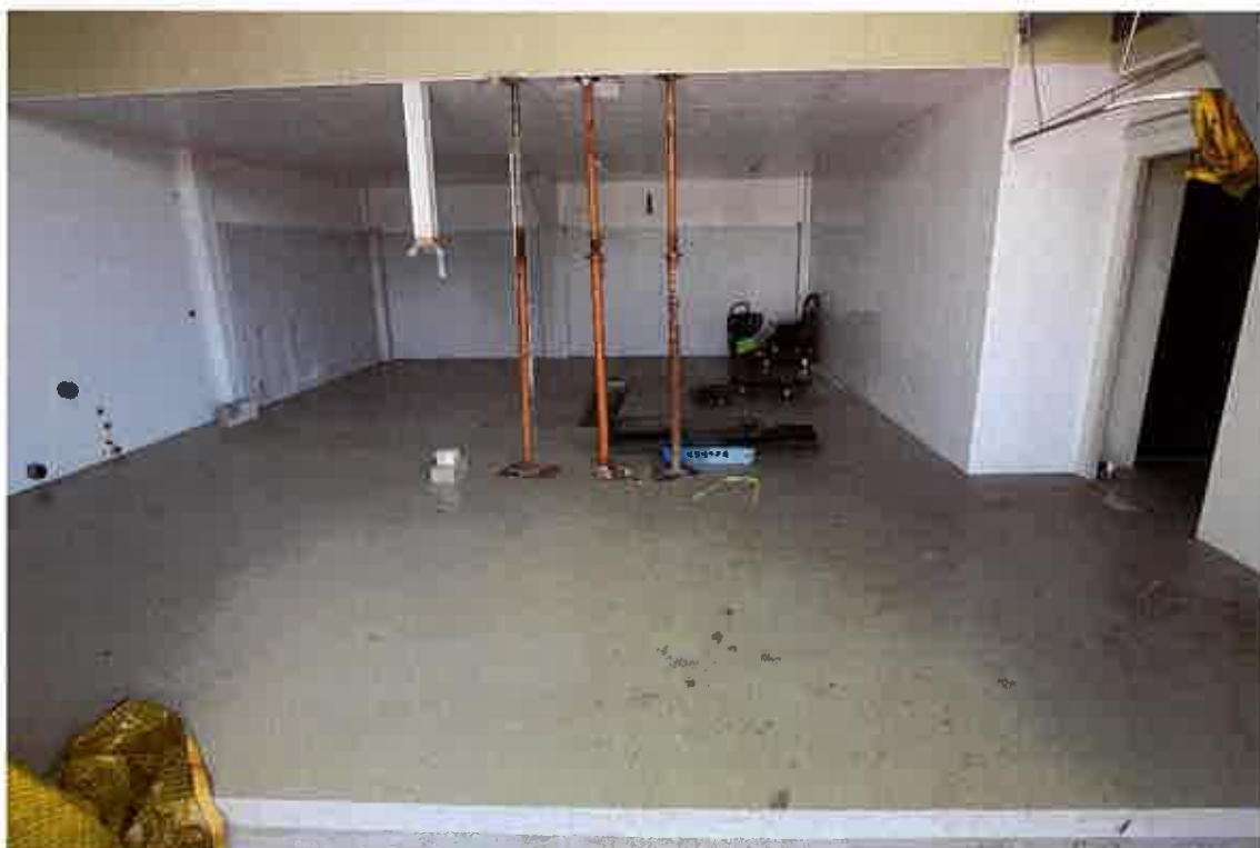
写真4 物件2建物 1階室内(倉庫2)
