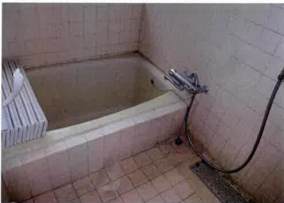
⑧屋内の状況
