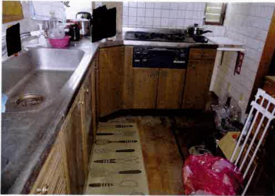
⑦屋内の状況
