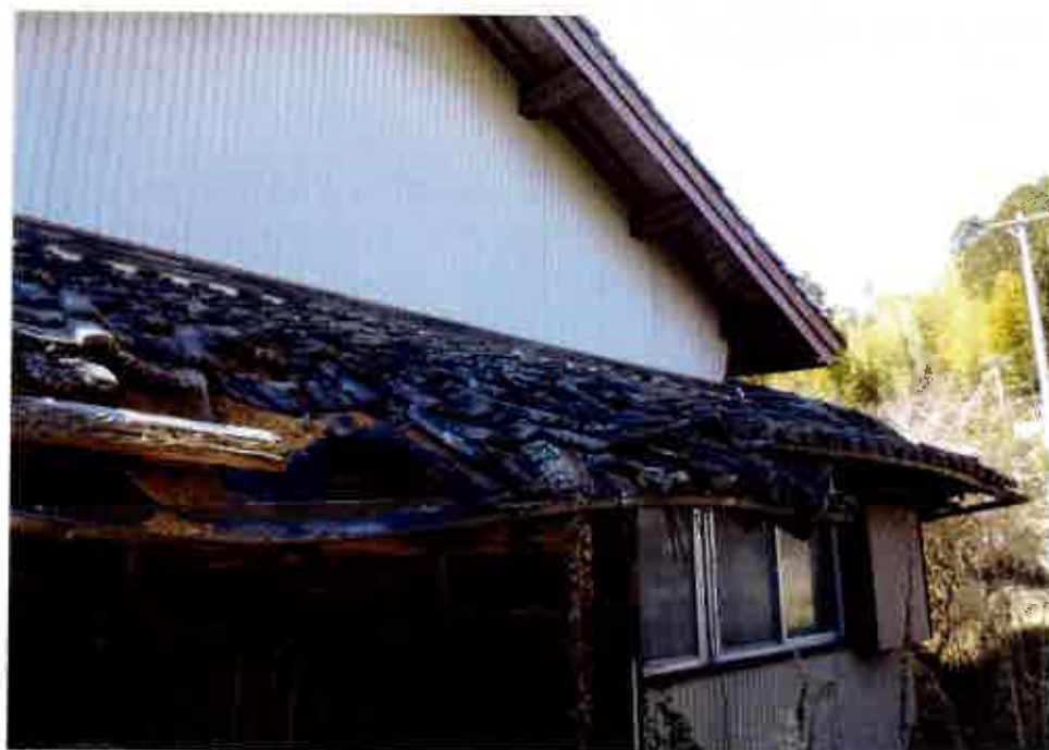
⑫屋外の状況 屋根の状況 (物件7) (主である 建物)
