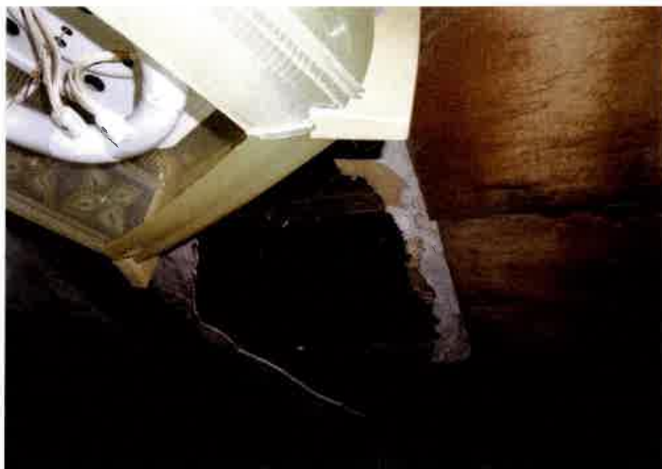
⑩屋内の状況 DKの天井 の状況 (物件7) (主である 建物)
