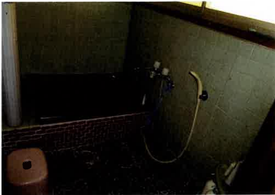
⑨屋内の状況 浴室 (物件7) (主である 建物)
