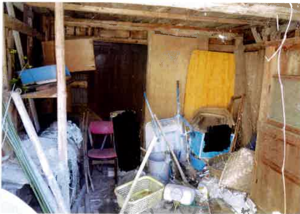
⑯屋内の状況 物置 1 (物件 7) (未登記 附属建物)
