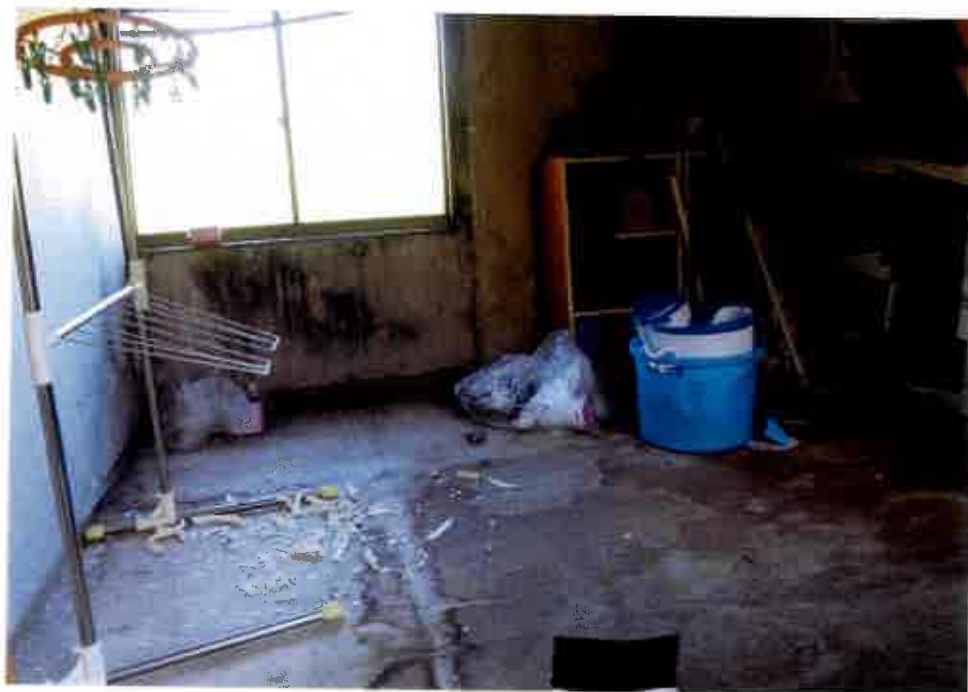
⑤屋内の状況 物置 3 (物件 6) (未登記 附属建物)
