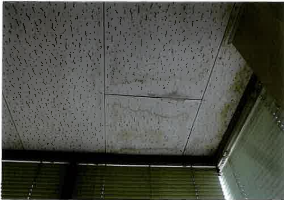
⑤屋内の状況 2階畳敷の 天井の状況
