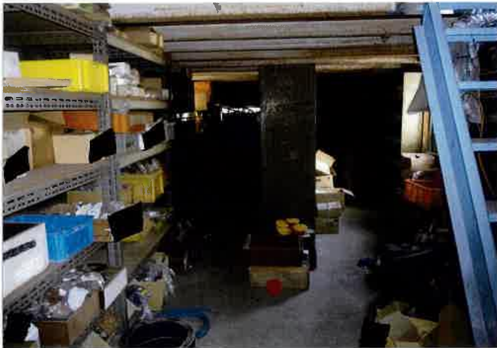
③屋内の状況 倉庫・車庫
