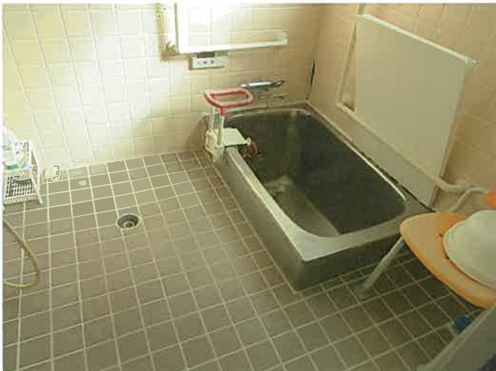
物件 2 附属建物内部 (浴室)
