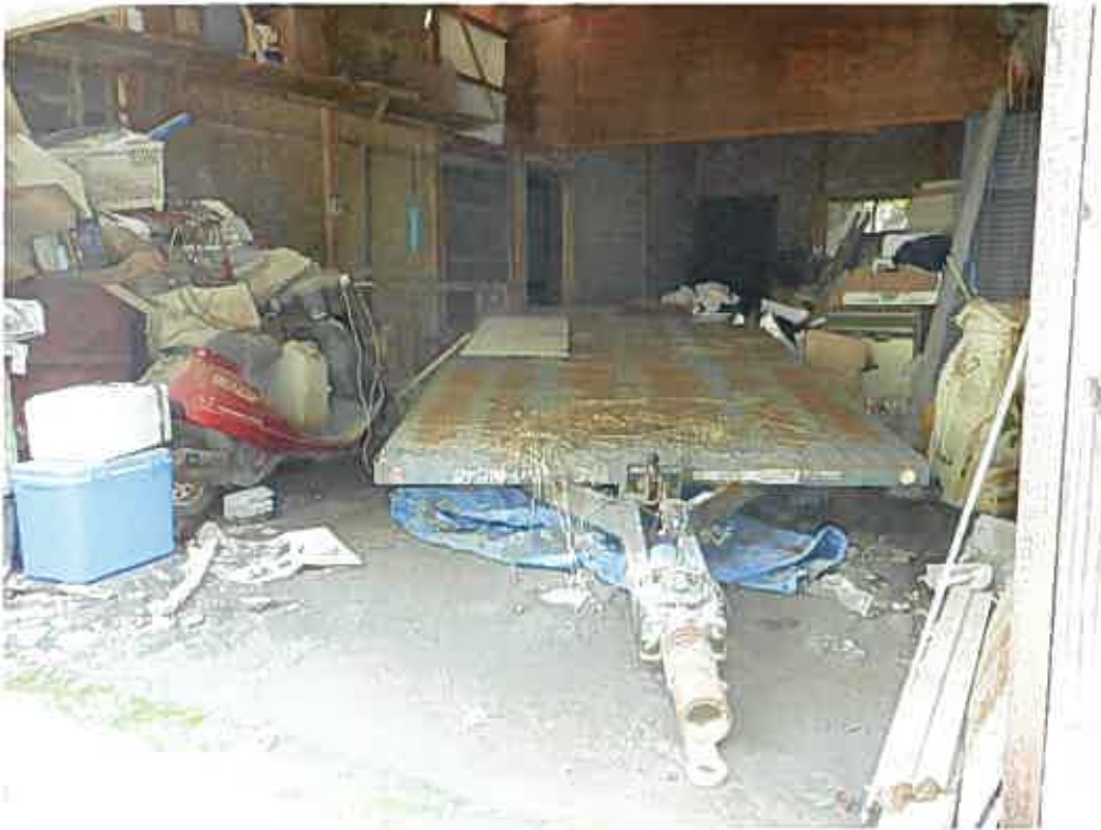
物件 2 主建物内部
