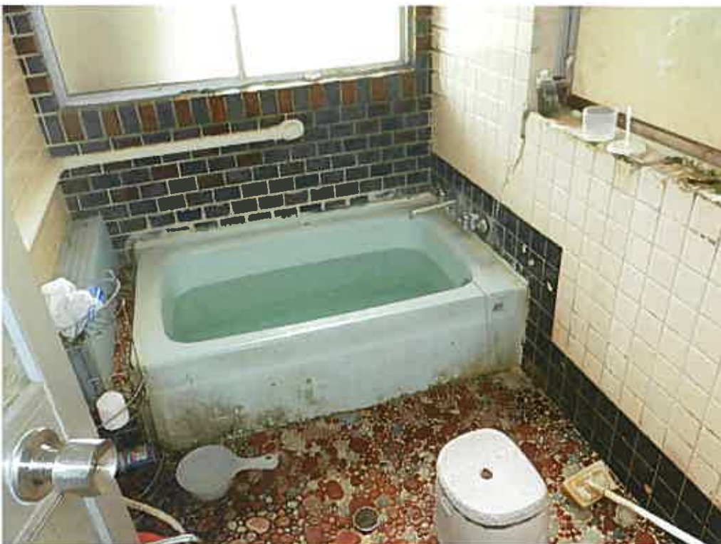
物件 3 主建物内部（浴室）
