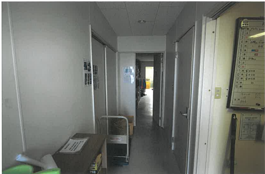
物件 1 2 建物 室内
