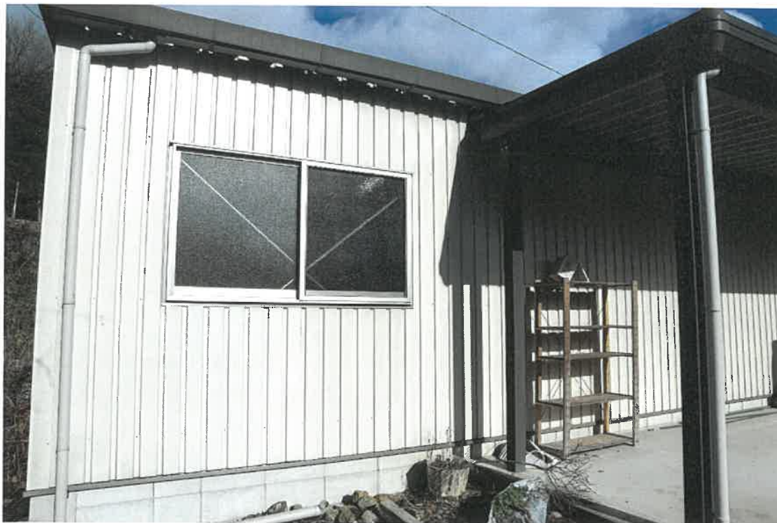
物件4 建附属建物の外壁の状況
