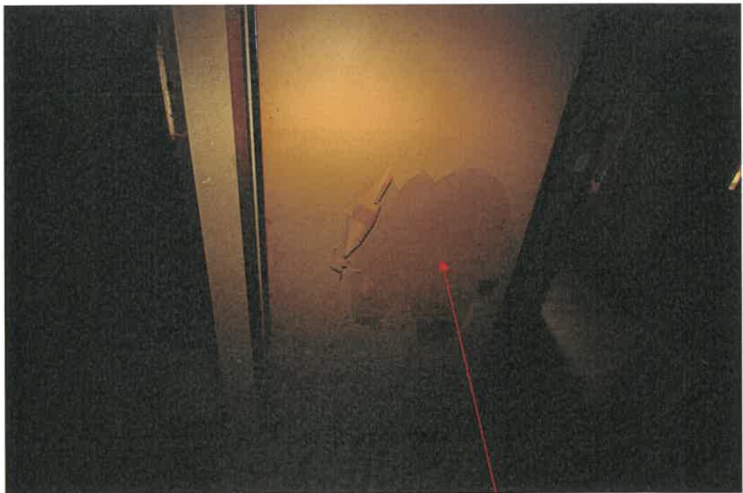
物件 2 建物 2 階室内
