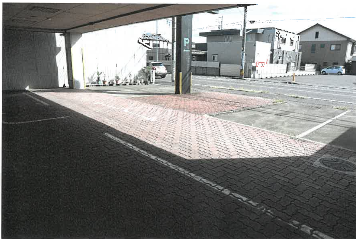
物件 2 建物 1 階の駐車場
