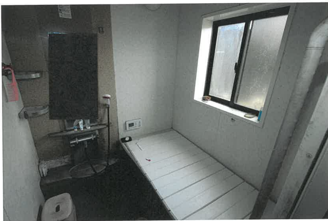
物件 2 建物 1 階室内
