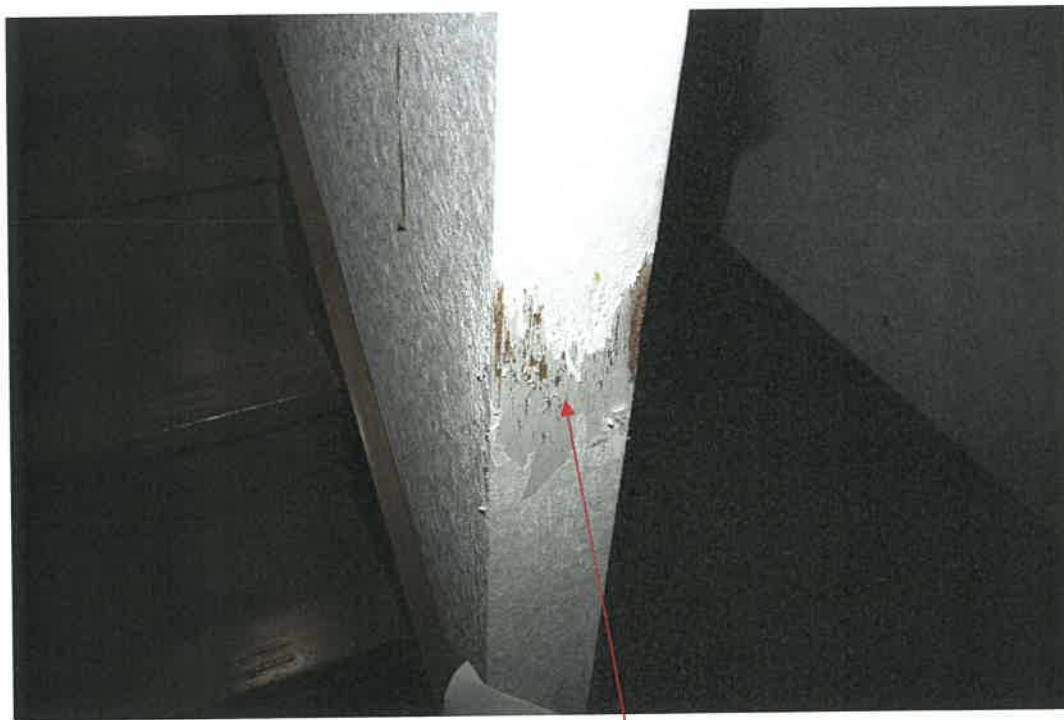
物件 2 建物 1 階室内
