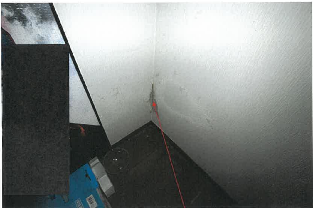
物件 2 建物 2 階室内
