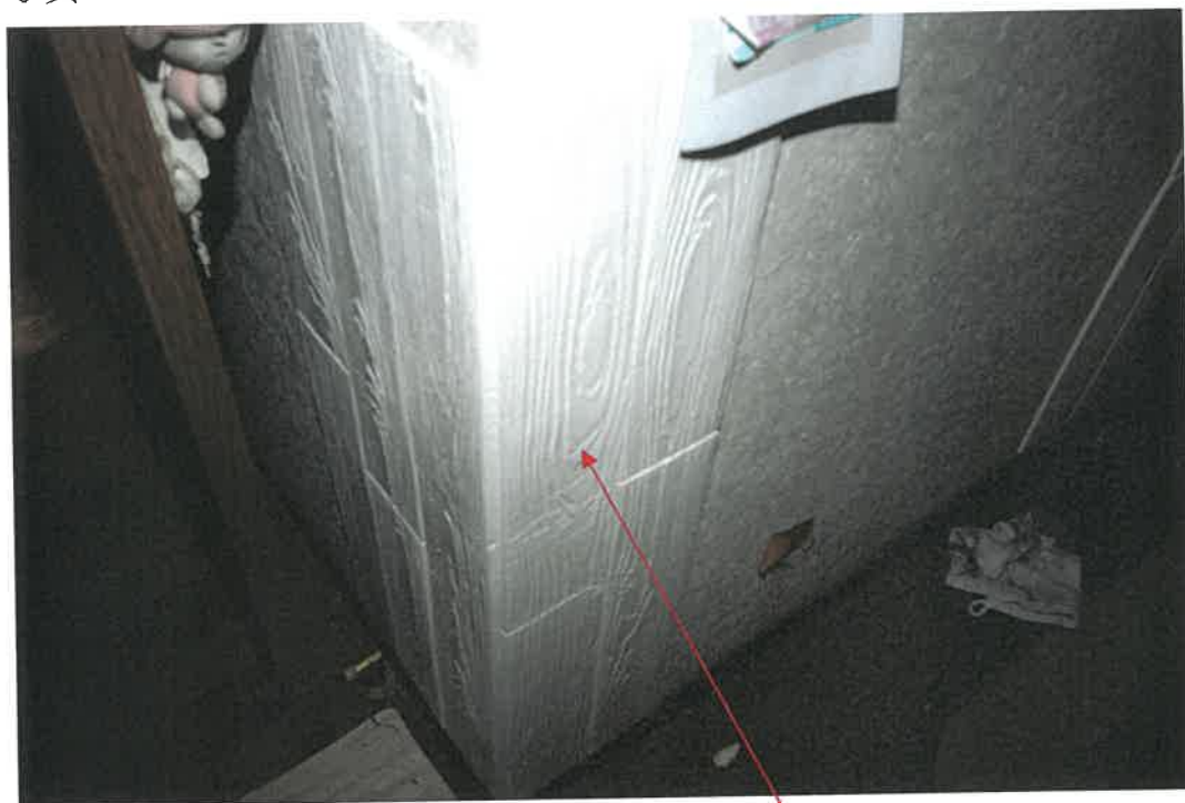
物件 2 建物 1 階室内
