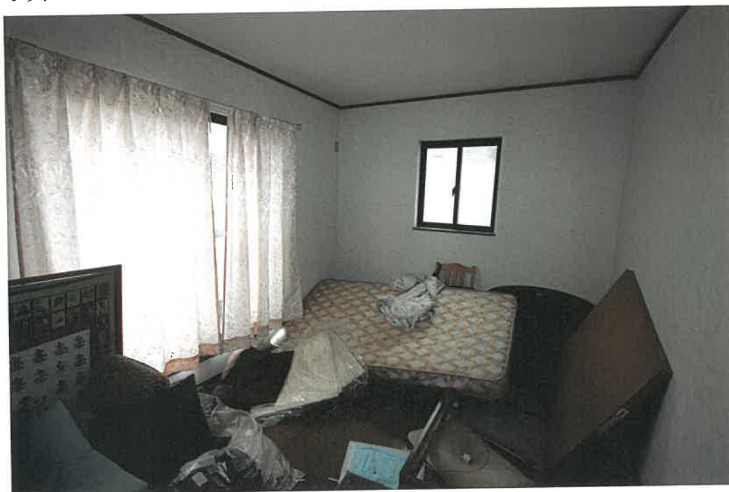
物件 2 建物 2 階室内
