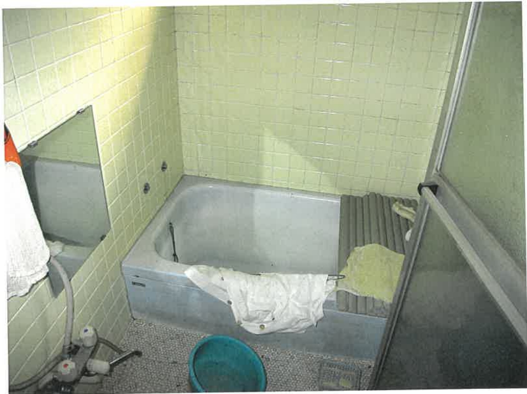
前同建物の1階室内
