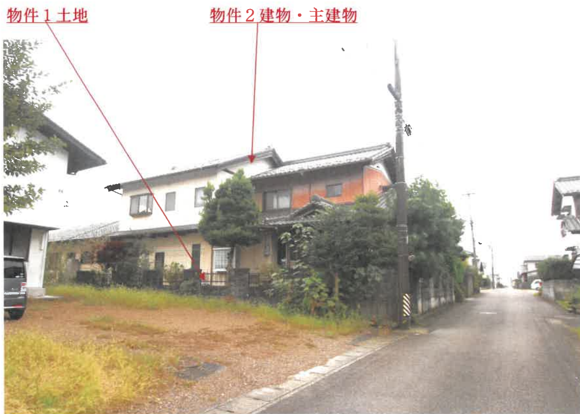
目的物件の現況写真
