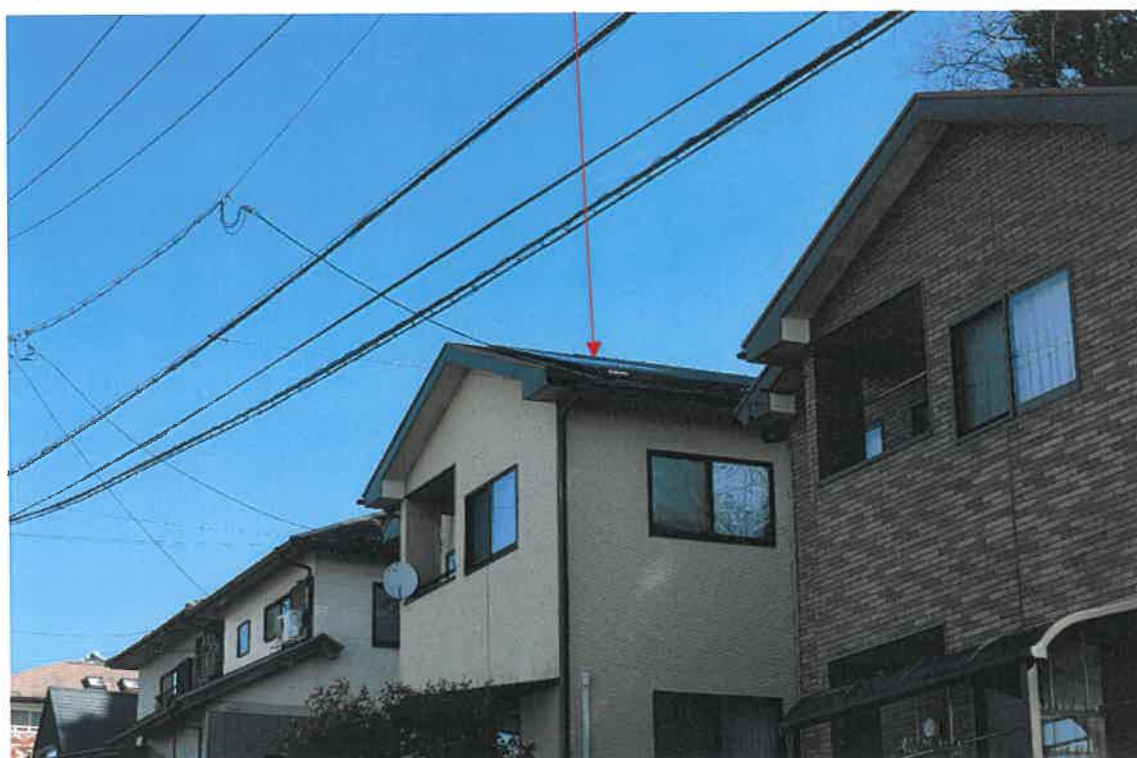
ソーラーパネルの設置状況
