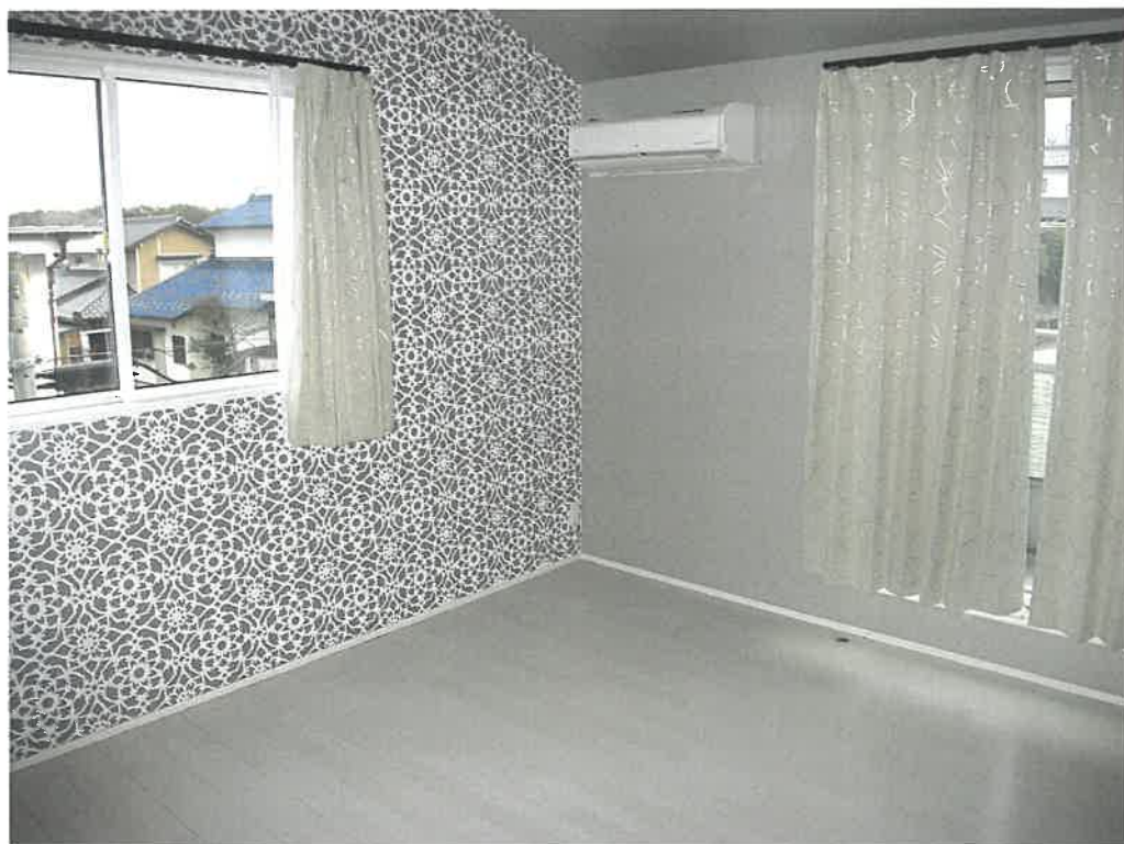
前同建物の2階室内
