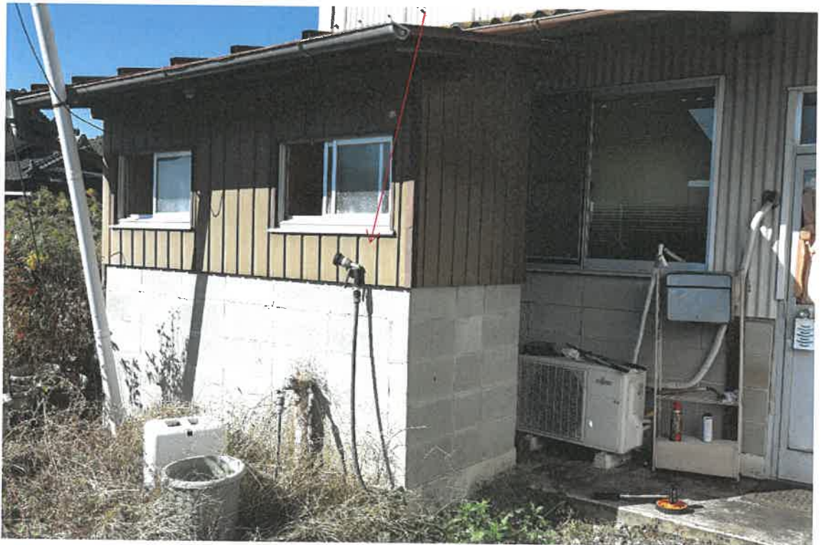
物件3 附属建物1
