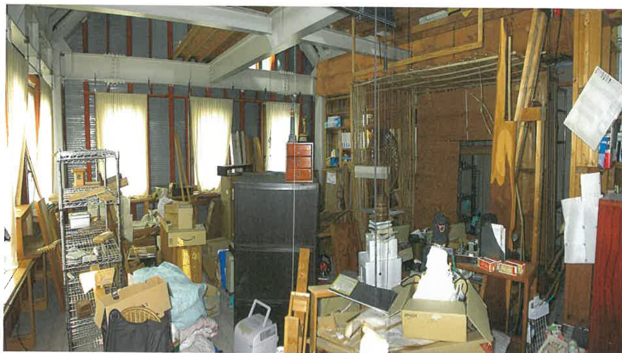
前同建物の2階室内
