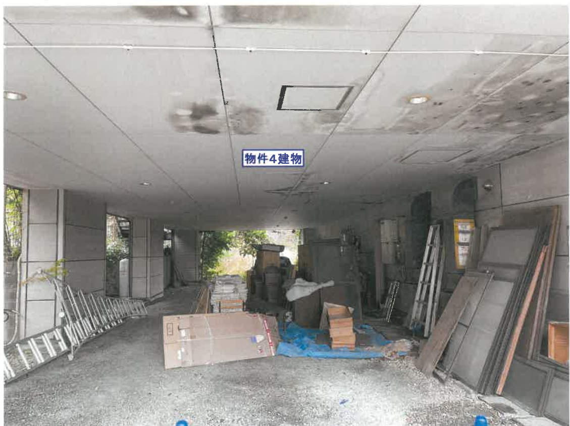
写真④ 物件4建物のピロティ部分を撮影
