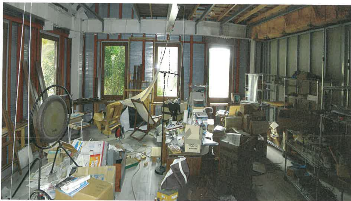
前同建物の2階室内
