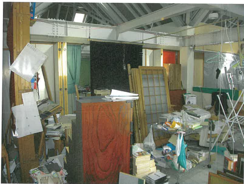
前同建物の2階室内
