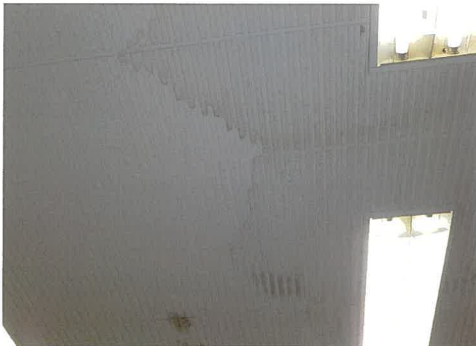
1階LDKの天井の雨漏り跡の状況
