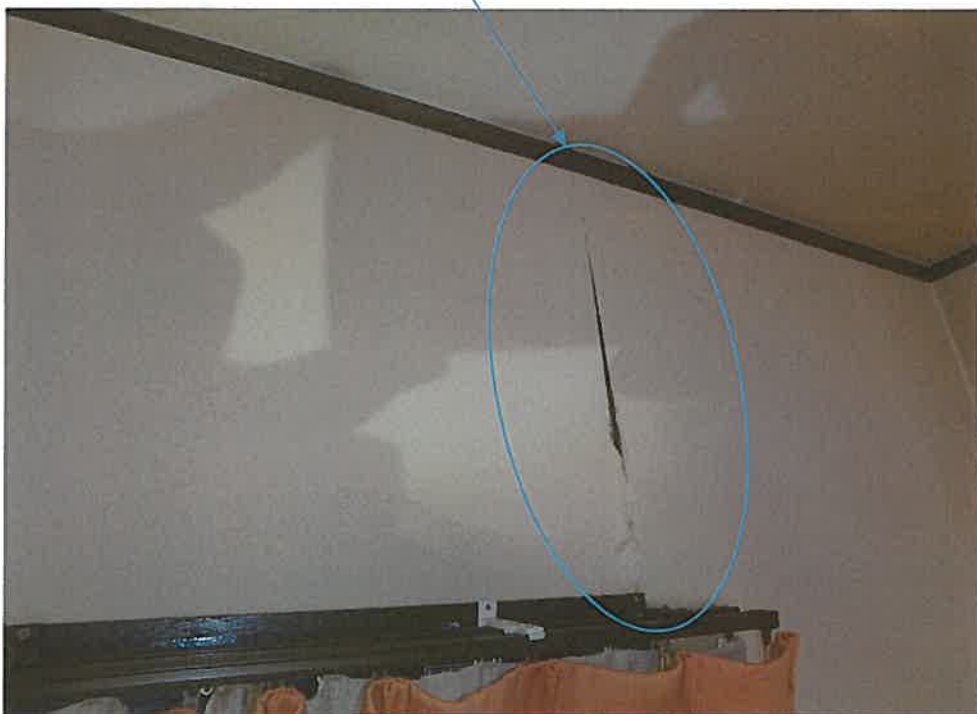
内壁（クロス）の損傷状況
