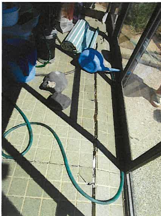
物件2 工作物(風除室)には幅約2.5mの亀裂
