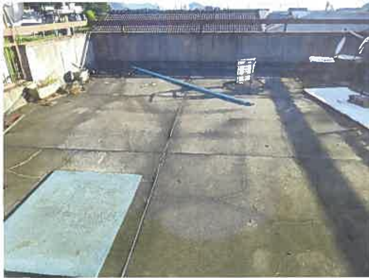
写真 2 2 (本件建物 3 階バルコニー)
