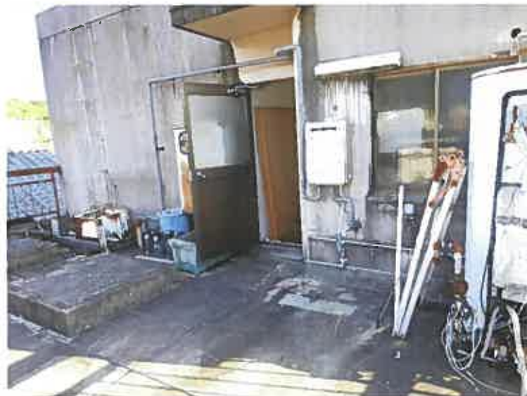
写真 2 3 (本件建物 3 階バルコニー)
