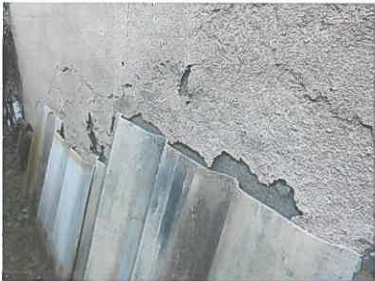
写真8 外壁の剥離
