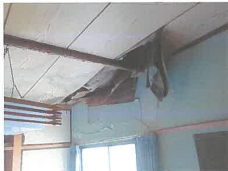
写真 3 0 漏水箇所
