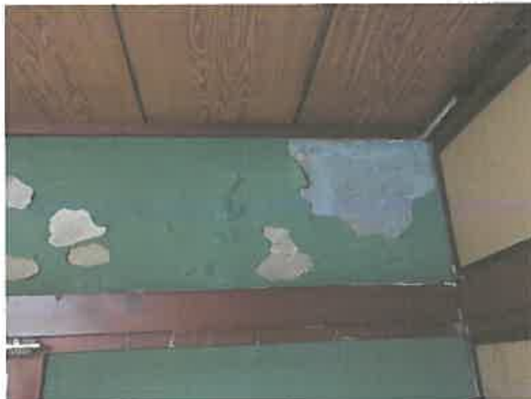
写真1 4 漏水箇所
