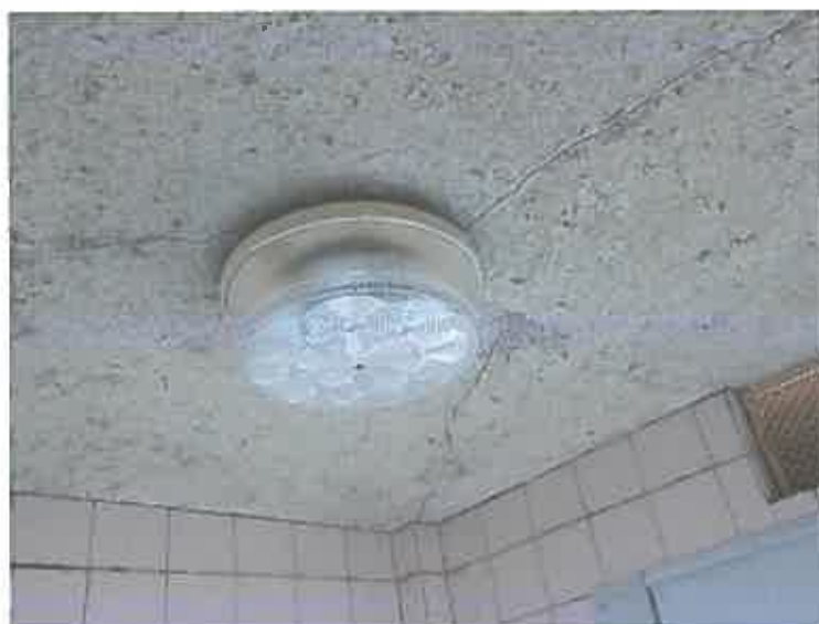
写真20 漏水箇所
