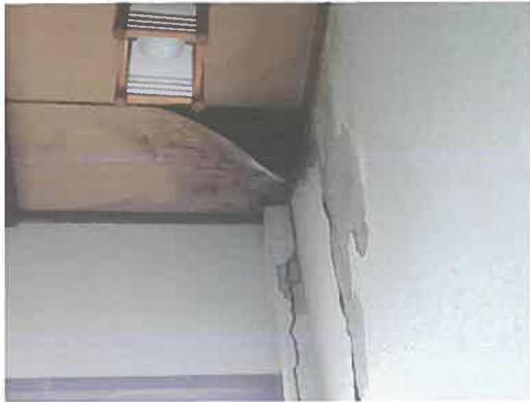
写真 2 2 漏水箇所
