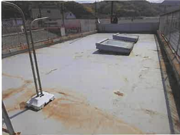
写真17 (本件建物 屋上 (北西付近から南東方向に撮影))
