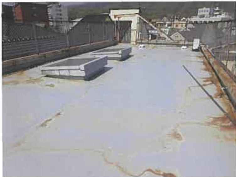
写真18 (本件建物 屋上 (南東付近から北西方向に撮影))
