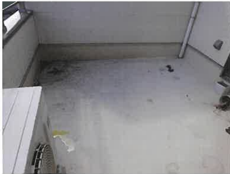
写真1 4 (本件建物 3階バルコニー)
