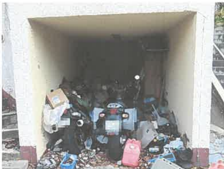
写真 3 附属建物 (掘込車庫)
