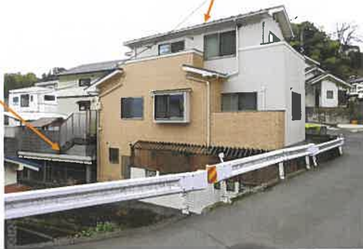
駐車場（構築物）
