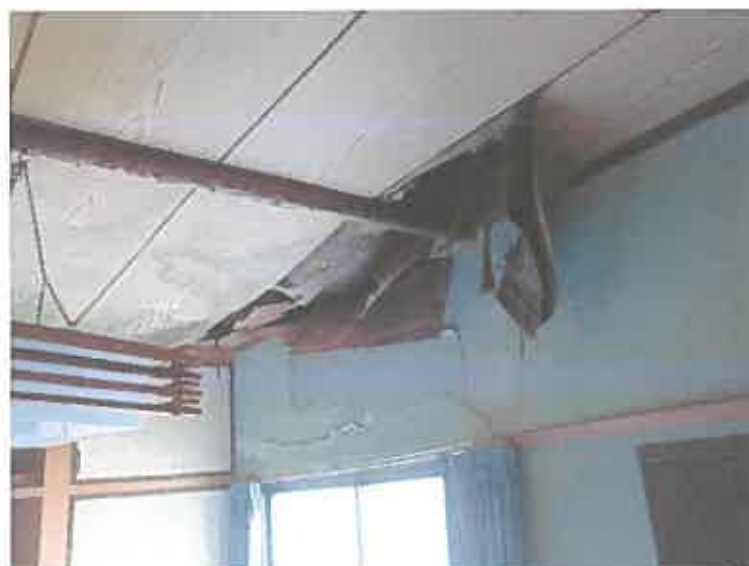
写真30 漏水箇所
