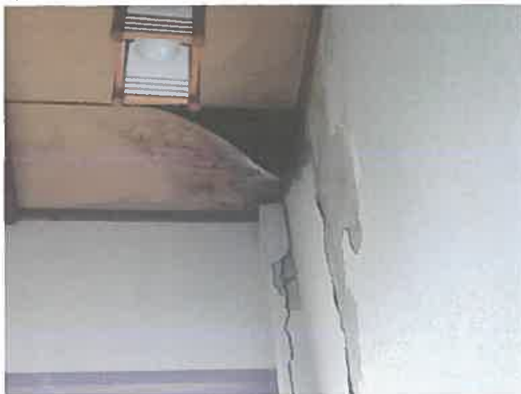
写真2 2 漏水箇所
