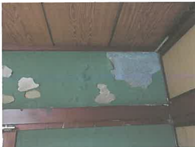
写真1 4 漏水箇所
